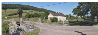
Site d'écluse vu d'aval. Phot. Thierry Kuntz IVR26_20122102213NUC4AQ
