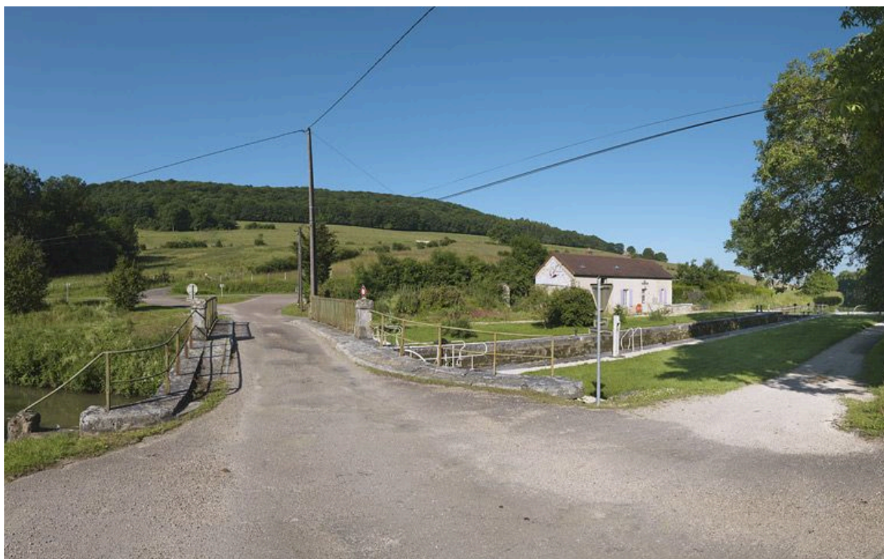
Site d'écluse vu d'aval.
