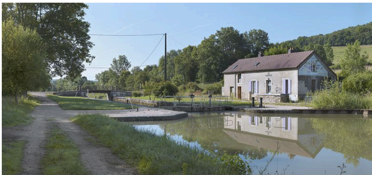
Site d'écluse vu d'amont.
