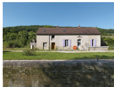
Maison éclusière de face. Phot. Thierry Kuntz IVR26_20122102215NUC4A
