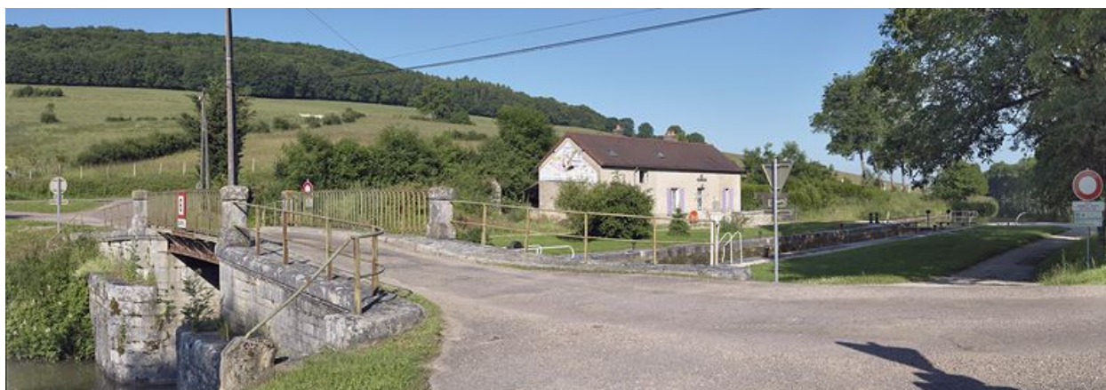
Site d'écluse vu d'aval.
