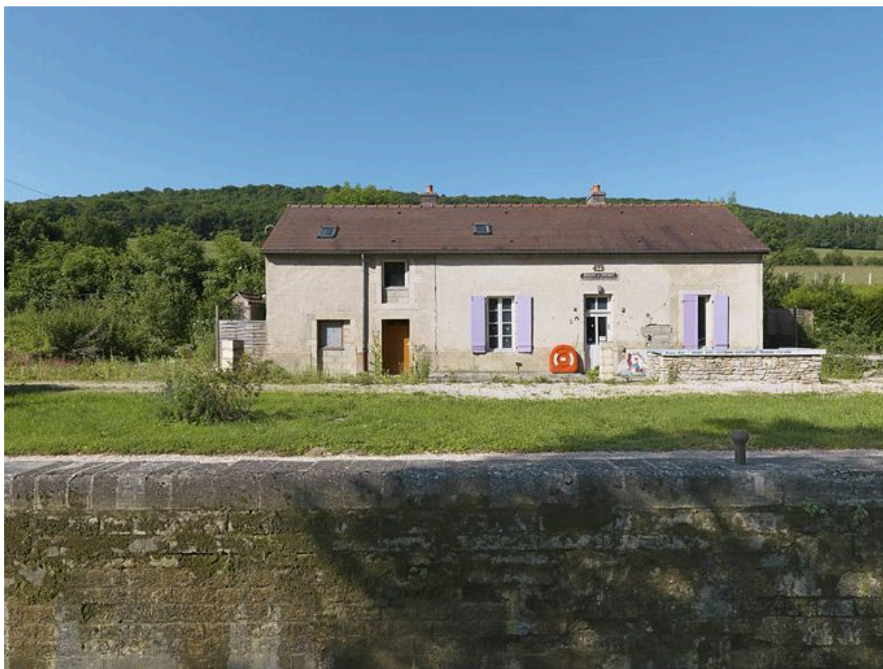
Maison éclusière de face.
