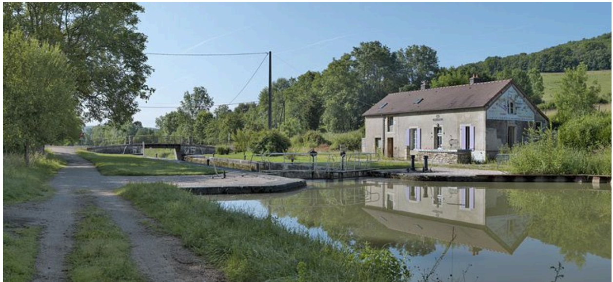
Site d'écluse vu d'amont.
