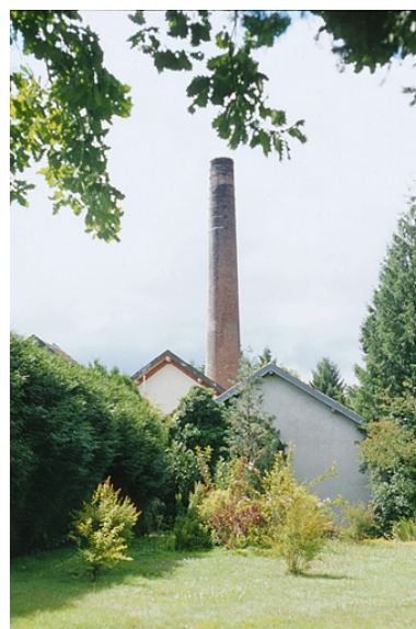
Pignons des ateliers de fabrication et cheminée. Phot. Yves Sancey IVR43_20009000193ZA
