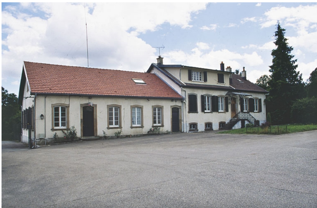
Les bureaux attenants au logement de contremaître.
