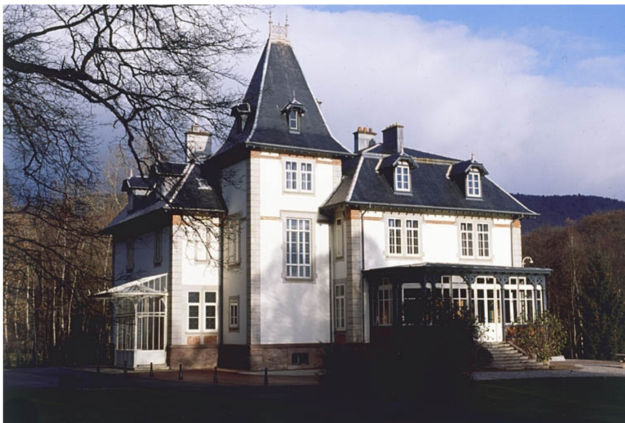
Façades sud du logement patronal.
