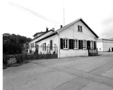
Les bureaux depuis l'entrée. Phot. Yves Sancey IVR43_20009000178X
