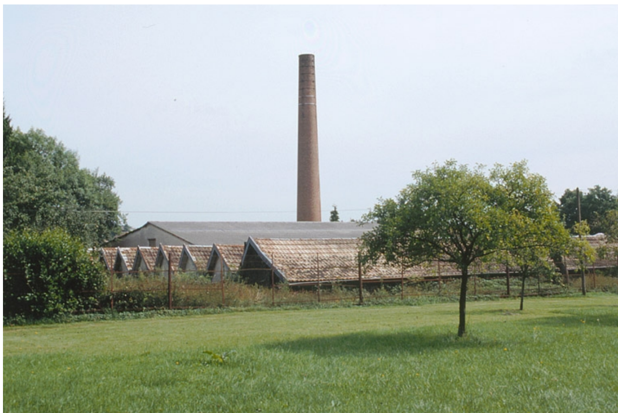
Ateliers de fabrication depuis le sud-ouest.
