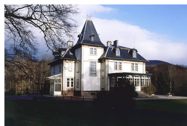
Le logement patronal depuis le sud. Phot. Jérôme Mongreville IVR43_20019000542ZA
