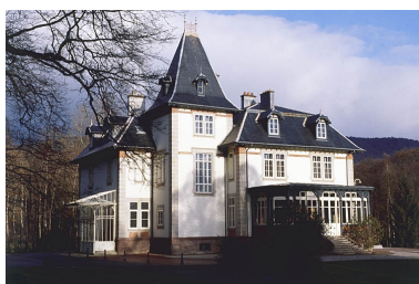
Façades sud du logement patronal. Phot. Jérôme Mongreville IVR43_20019000540ZA
