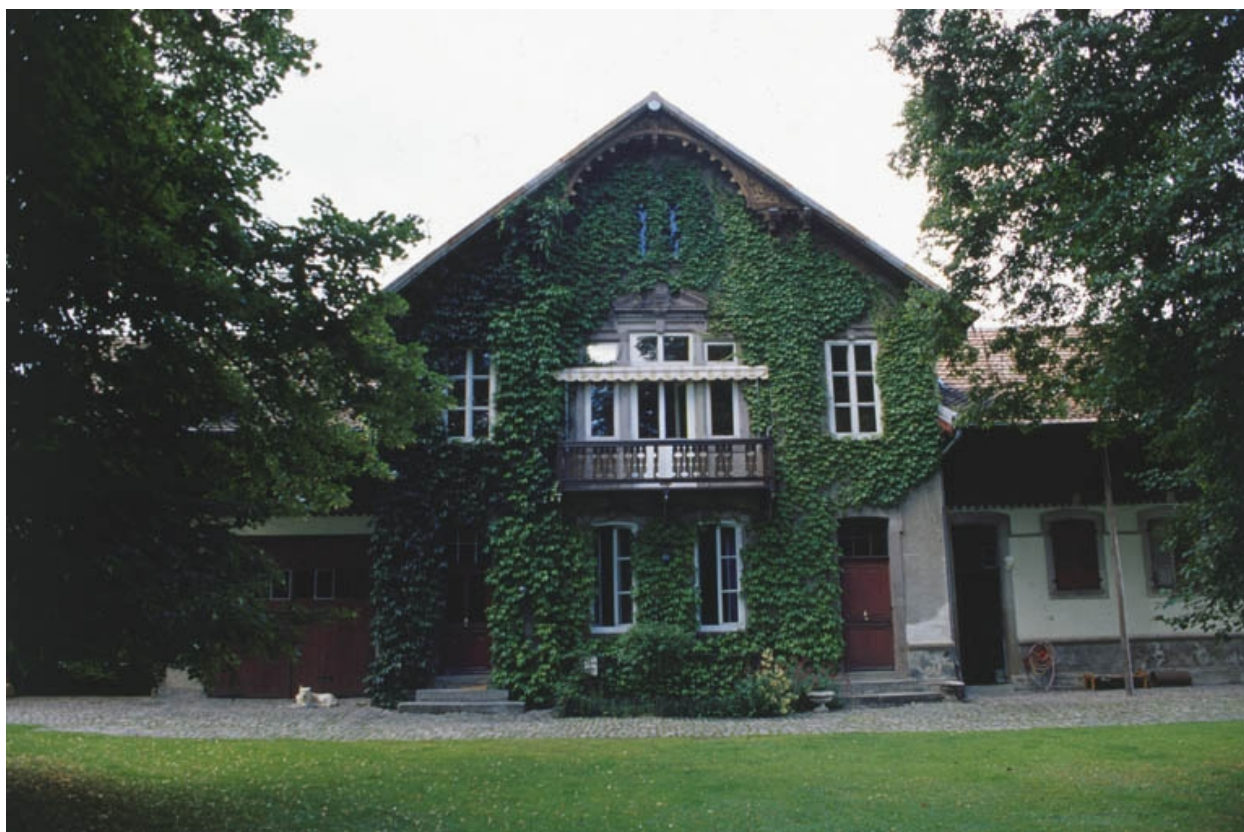
Mur-pignon du logement de la ferme.
