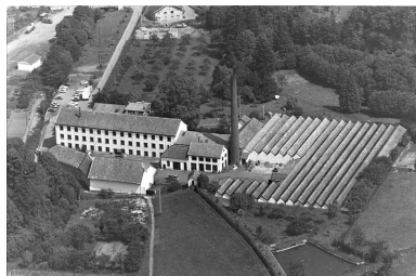
Vue aérienne du tissage Erhard à Rougemont-le-Château. Phot. Jérôme Mongreville IVR43_20029000002X
