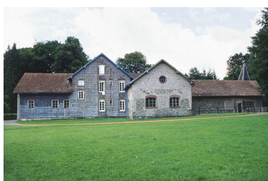
Façade postérieure de la ferme. Phot. Yves Sancey IVR43_20009000197ZA
