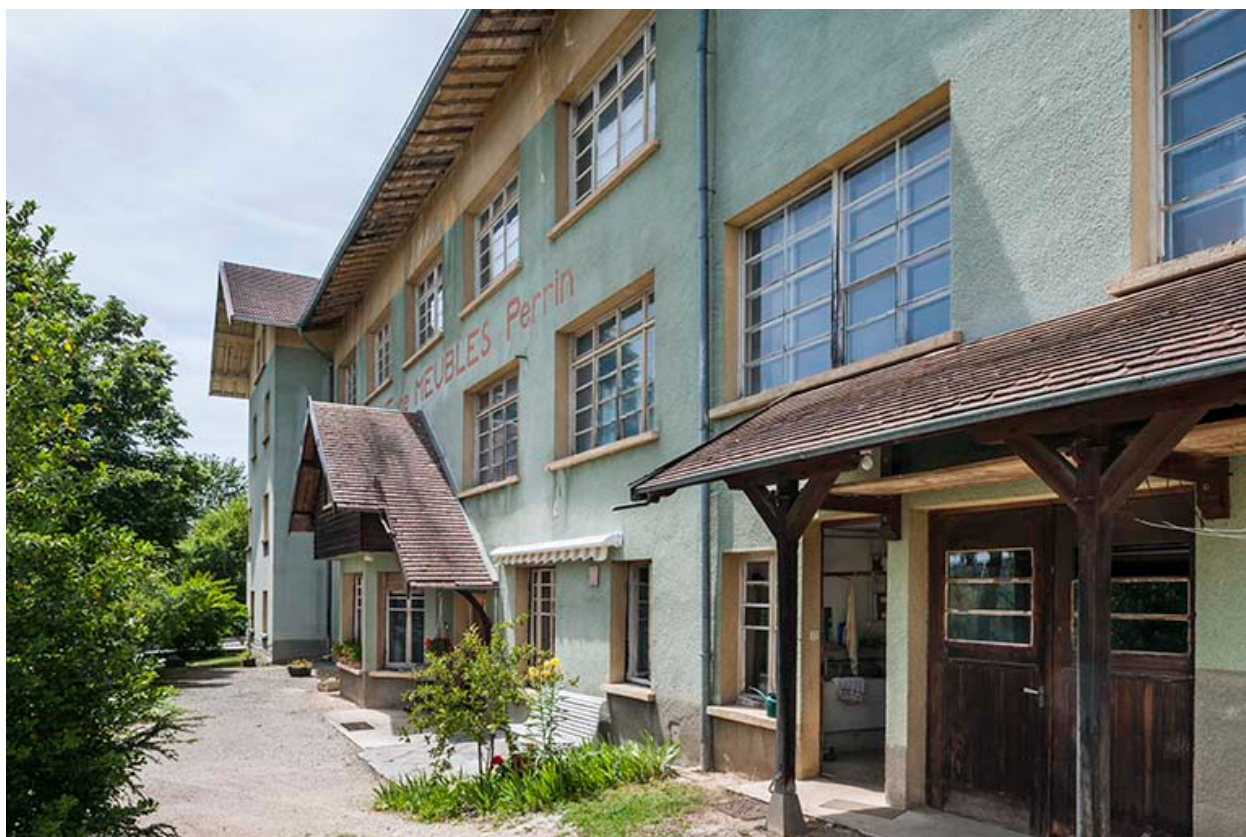
Détail de la façade est.
