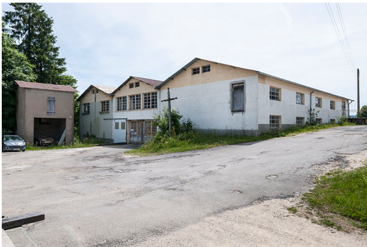
Extensions postérieures de l'atelier de menuiserie.
