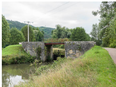
Vue du pont.
