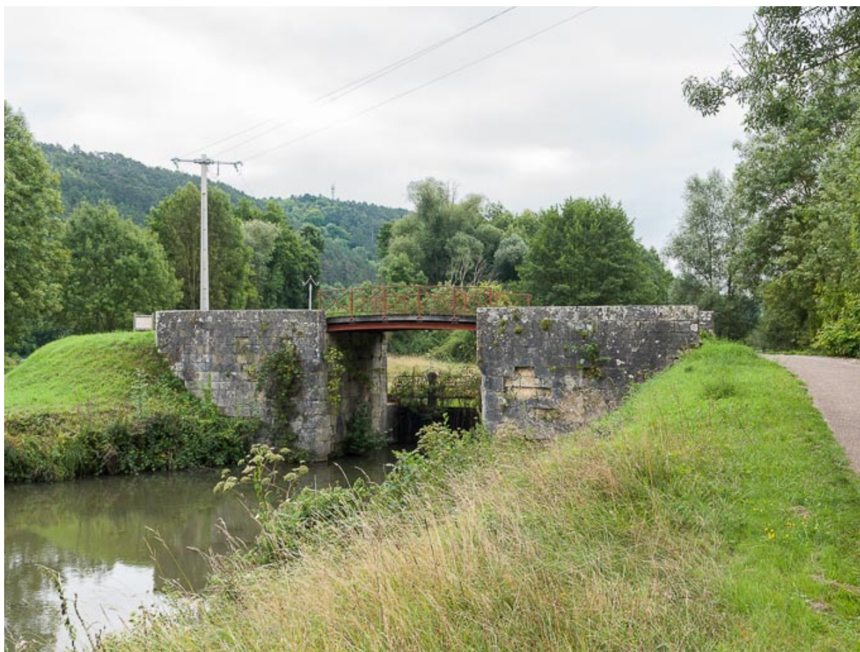
Vue du pont.
