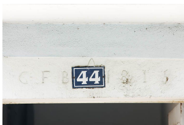
Détail du linteau de porte. Phot. Jérôme Mongreville IVR43_20112501444NUC4A
