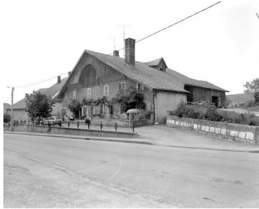
Ferme située 25 Grande Rue. Phot. Bernard Lardière IVR43_19782500218X
