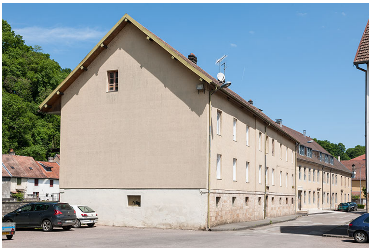
Logement occidental. Vue depuis le sud.
