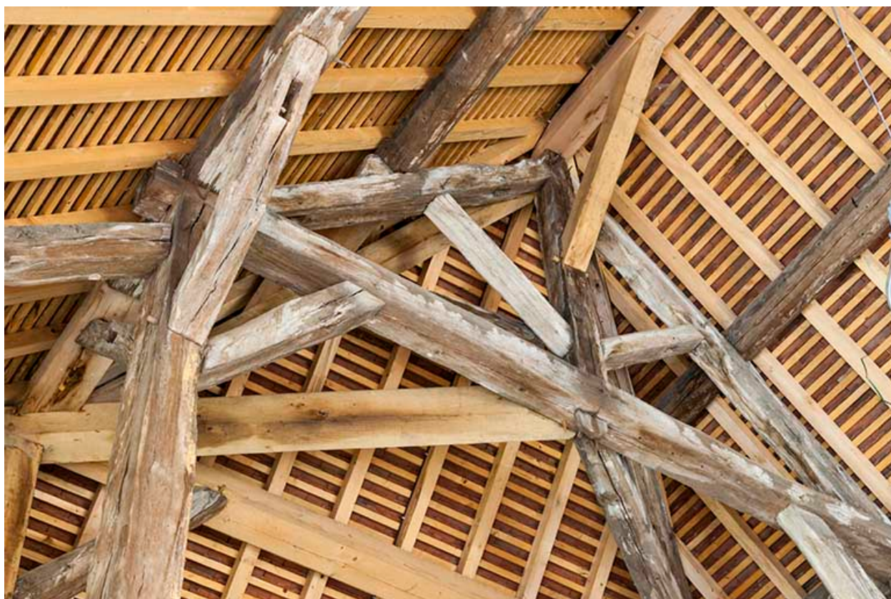
Détail de la charpente de la croupe.
