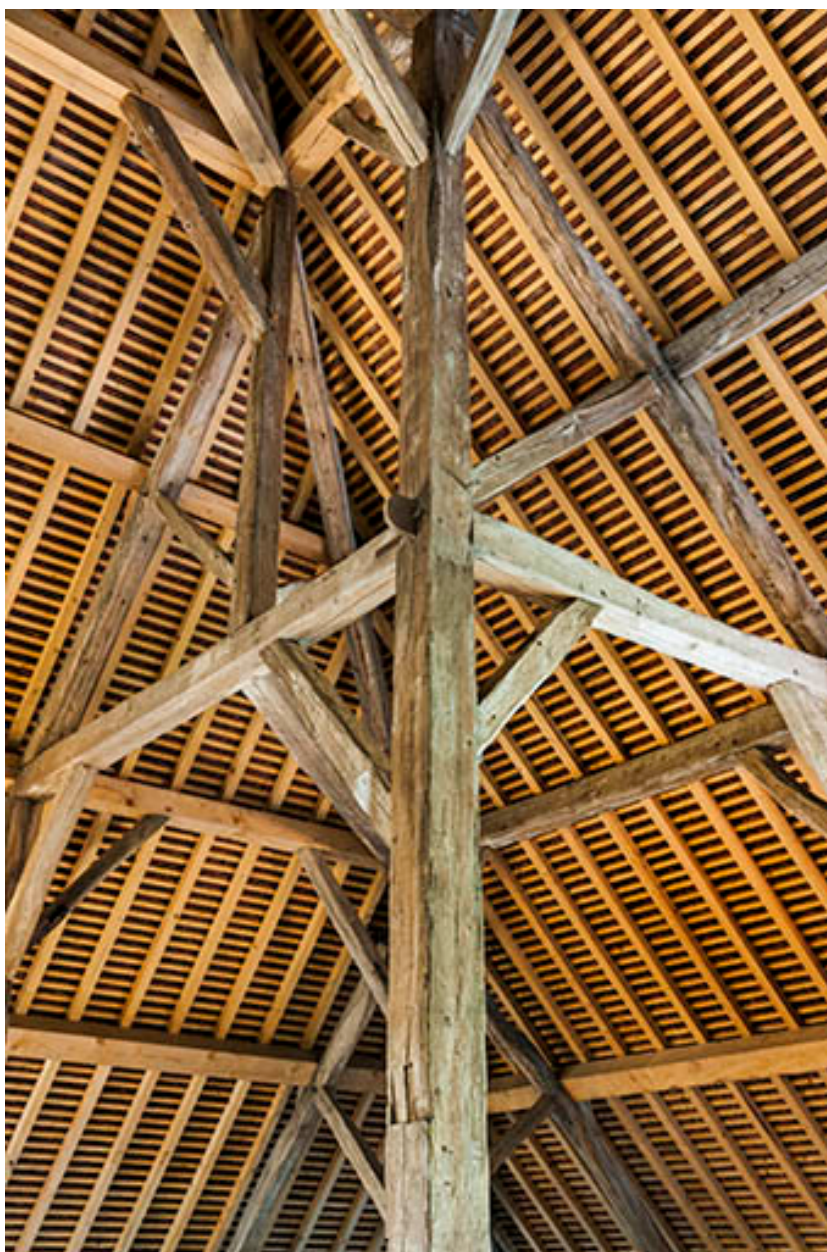
Charpente du séchoir. Détail de la croupe.
