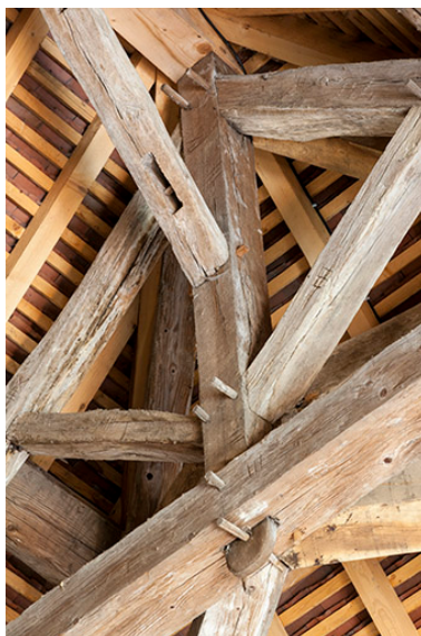
Assemblage de la ferme de la croupe. Détail. Phot. Jérôme Mongreville IVR43_20162501144NUC4A
