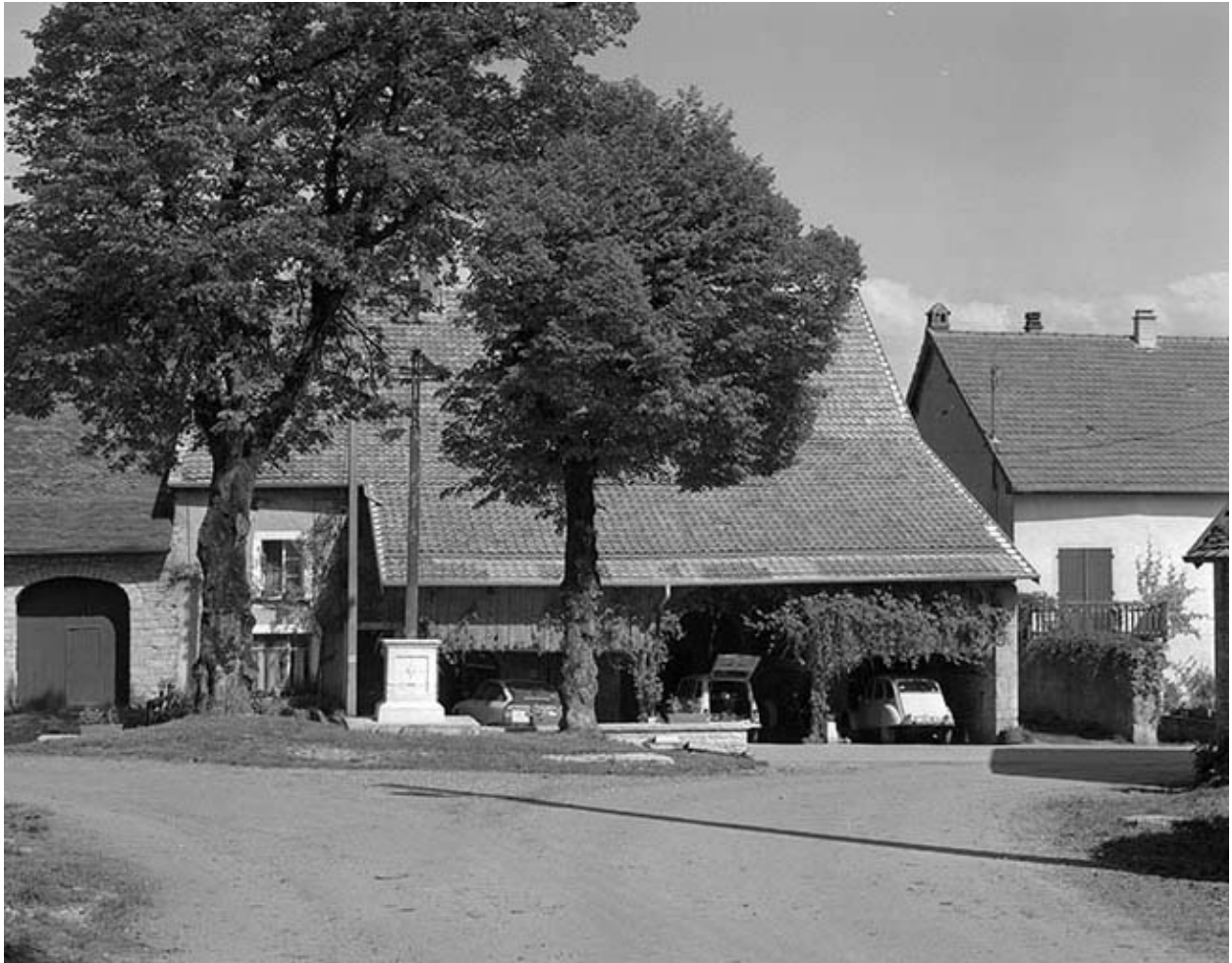
Façade antérieure vue de face en 1981.
