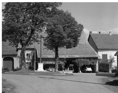
Façade antérieure vue de face en 1981.
