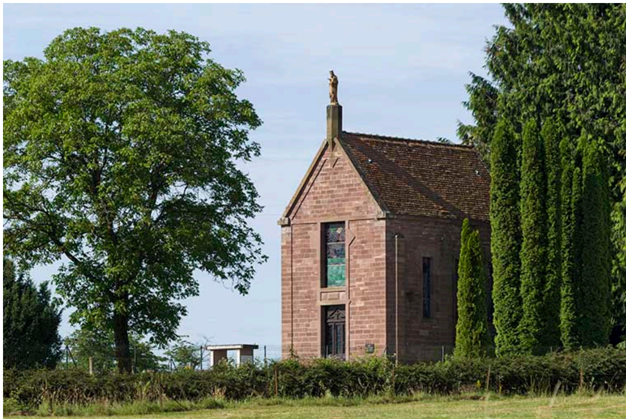
Façade principale de la chapelle.
