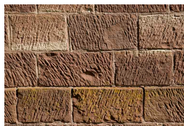
Grès des Vosges, gros oeuvre de la chapelle. Phot. Sonia Dourlot IVR43_20157001067NUC2A
