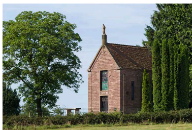
Façade principale de la chapelle.
