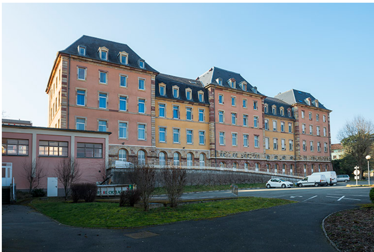
Lycée Condorcet : aile est du grand lycée.
