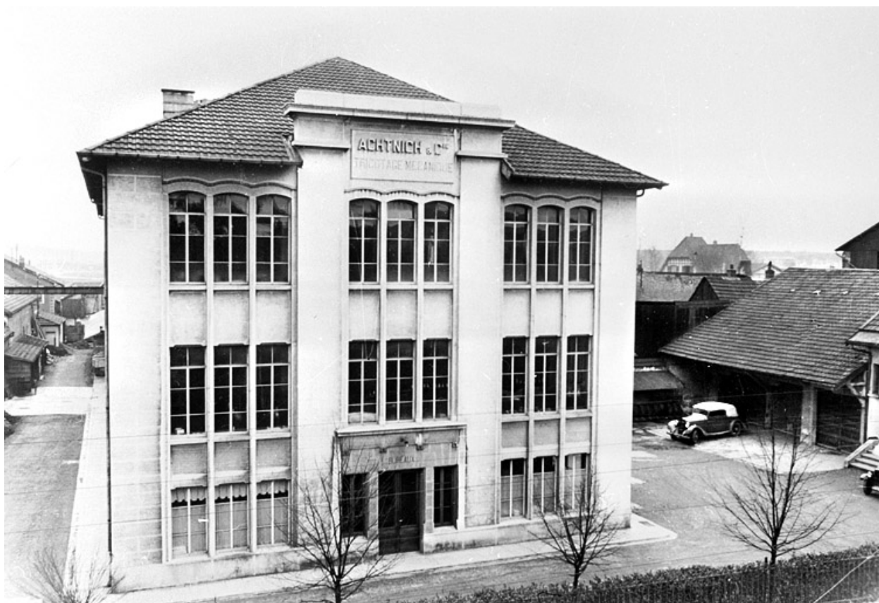
Façade nord de l'usine.
