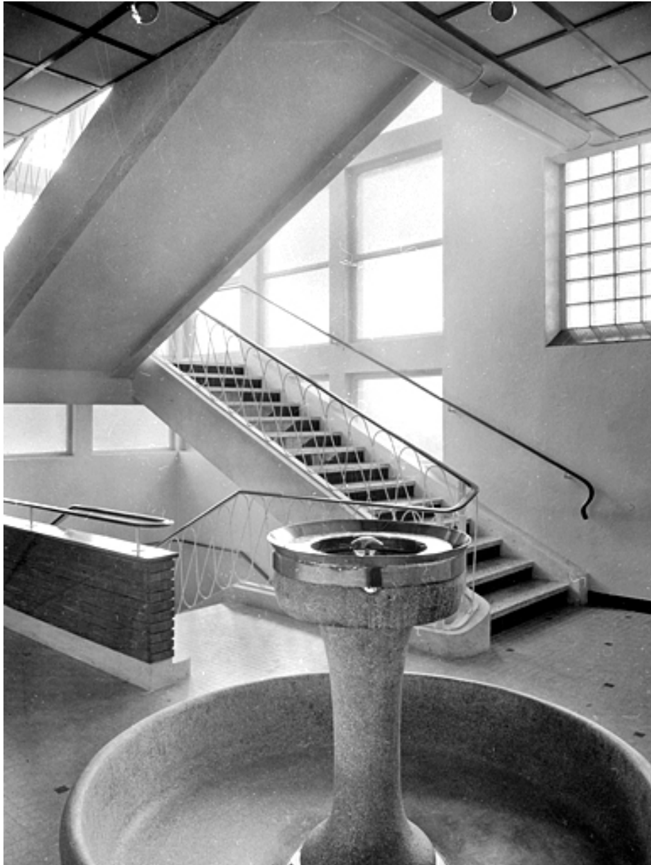
Vue intérieure du nouvel escalier.
