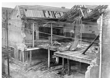
Destruction des ateliers sud en juin 1944. Phot. Yves Sancey IVR43_20009000897X
