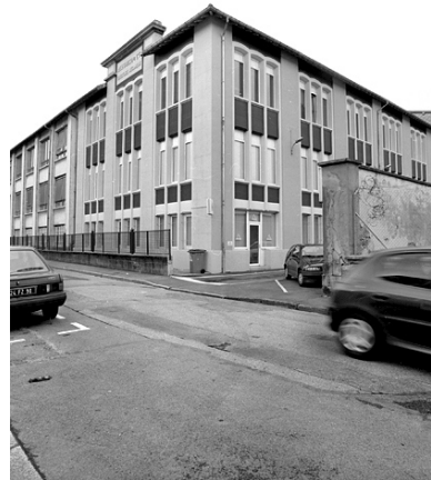
Angle sud-est des deux ateliers. Phot. Yves Sancey IVR43_20009000615X
