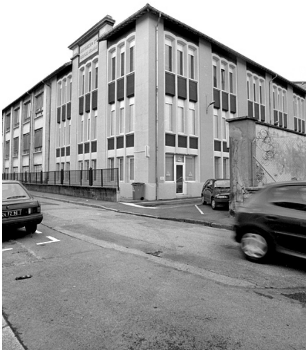
Angle sud-est des deux ateliers.
