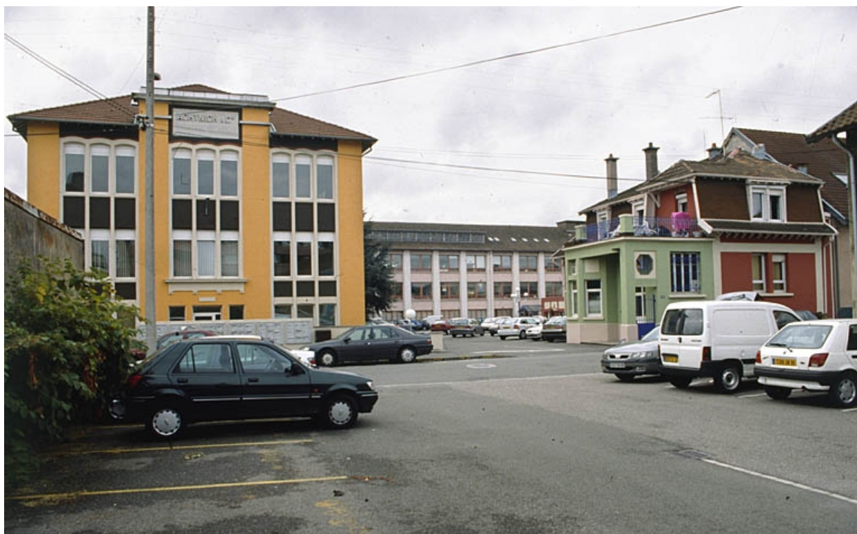
Vue de l'entrée depuis le nord.
