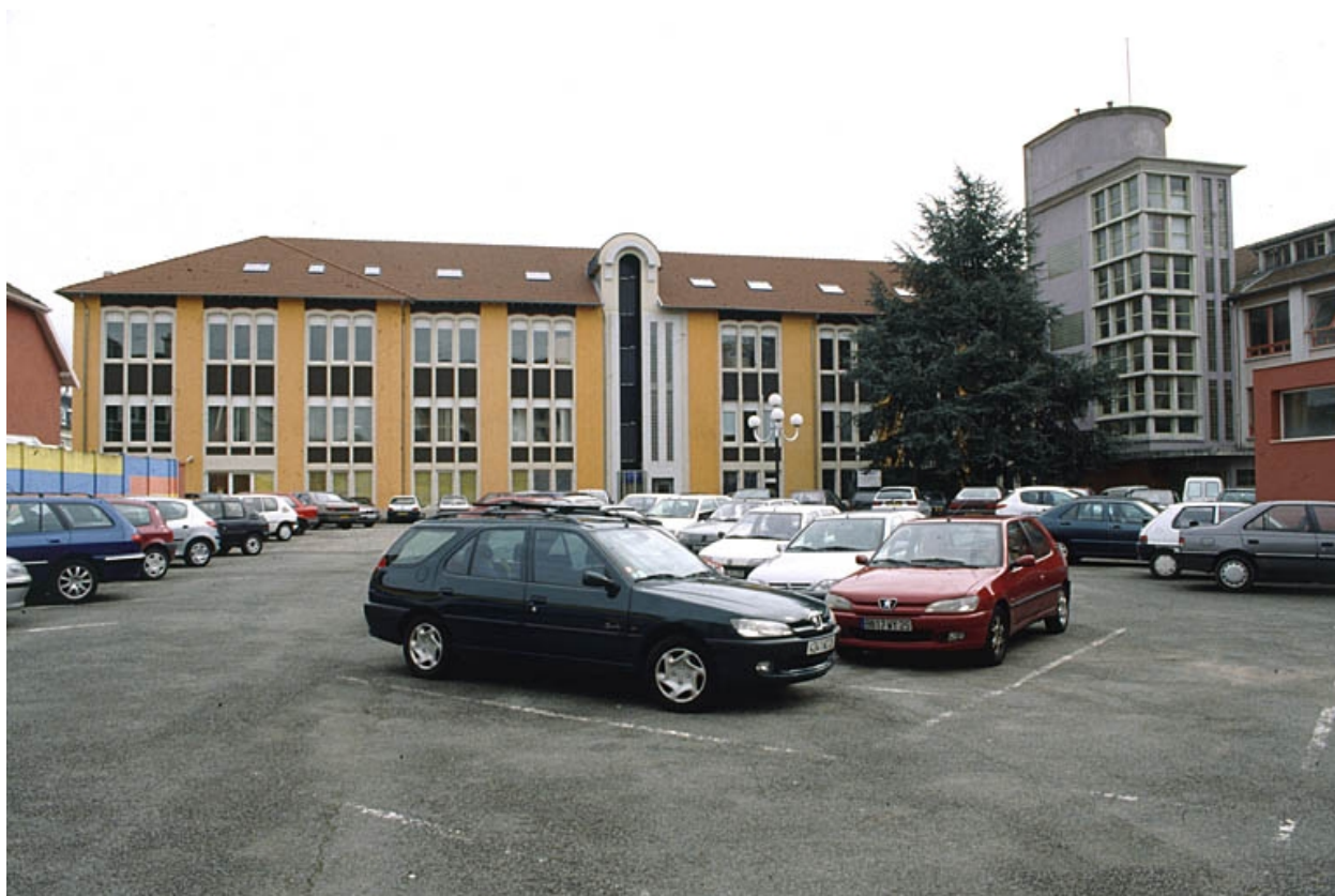
Façade ouest de l'atelier depuis la cour.
