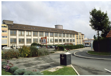
Extension sud de l'atelier de fabrication. Phot. Yves Sancey IVR43_20009000617ZA
