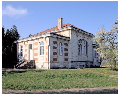
Façades est et nord. Phot. Jérôme Mongreville IVR43_20022501157XA
