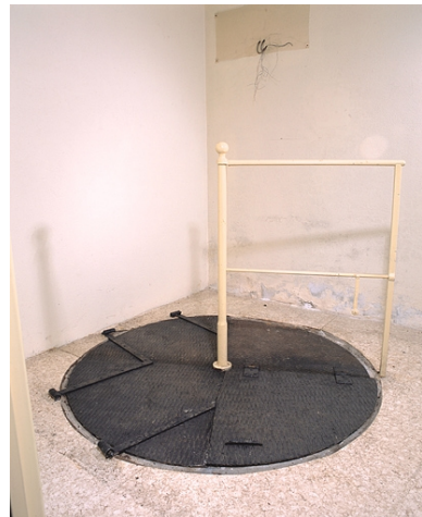
Sous-sol, salle ouest : puits des pendules à pression constante, trappe fermée. Phot. Jérôme Mongreville IVR43_20022501186XA
