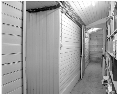
Sous-sol : boiseries de la salle est. Phot. Jérôme Mongreville IVR43_20022501144X
