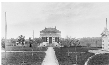
[Vue d'ensemble de la façade est de la bibliothèque et de l'allée d'arbres qui la précède], limite 19e siècle 20e siècle. Phot. Yves Sancey IVR43_20042500102X
