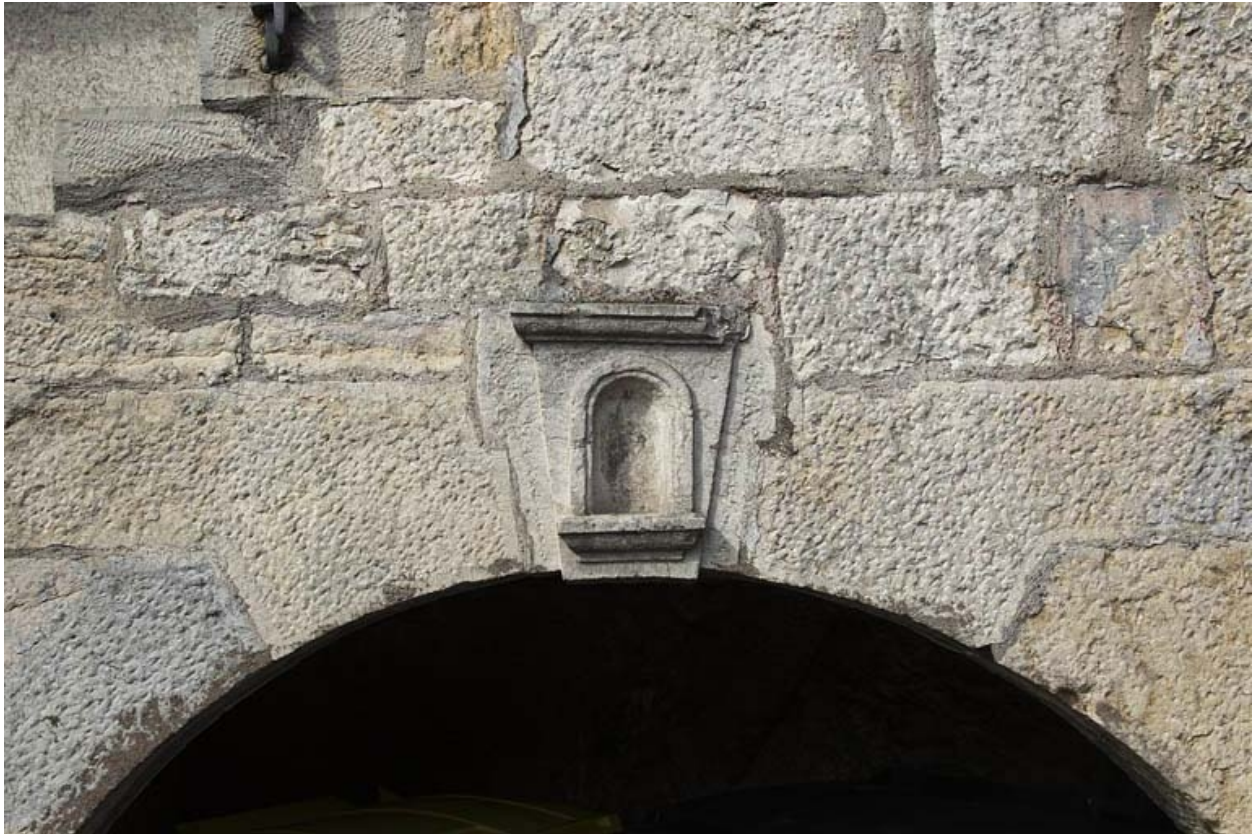
Détail d'une niche : 72 rue du Faubourg Rivotte.
