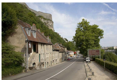
Vue d'ensemble, de trois quart gauche. Phot. Yves Sancey IVR43_20112501674NUC2A
