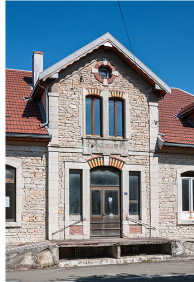
Elévation du pignon central. Phot. Jérôme Mongreville IVR43_20142501301NUC4A
