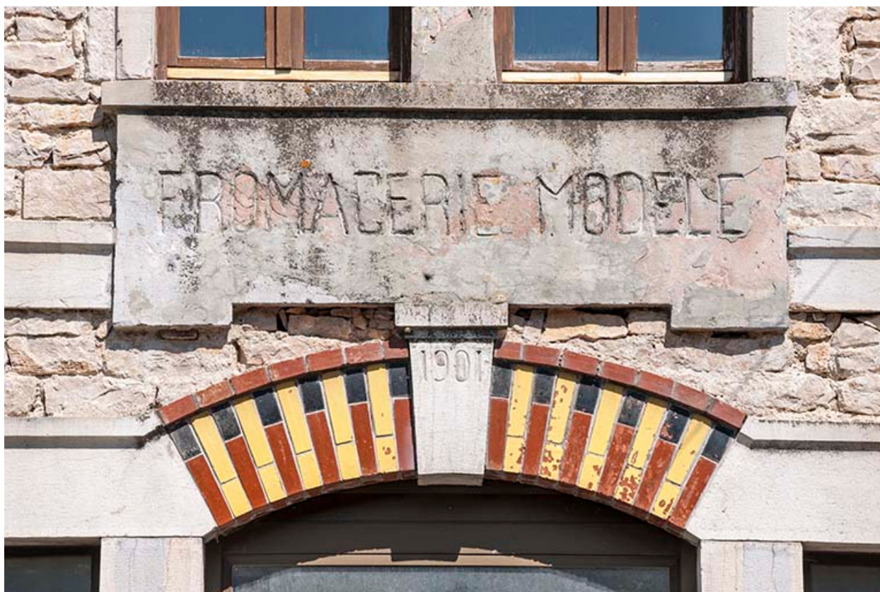
Façade sud. Inscription sur le pignon.
