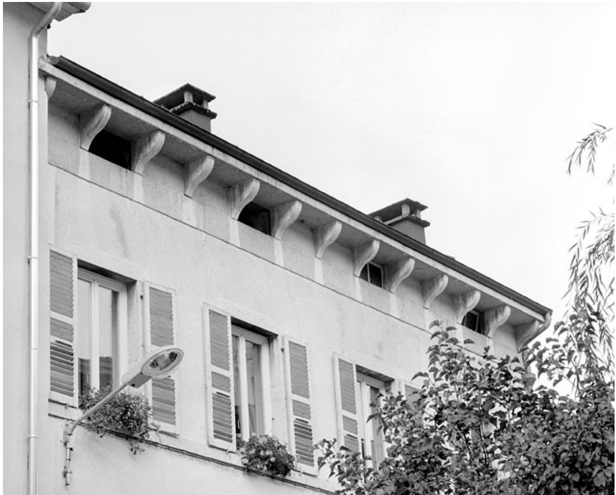
Elévation antérieure : baies du deuxième étage et du comble à surcroît, corniche et corbeaux.
