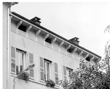
Elévation antérieure : baies du deuxième étage et du comble à surcroît, corniche et corbeaux. Phot. Yves Sancey IVR43_20033900681X
