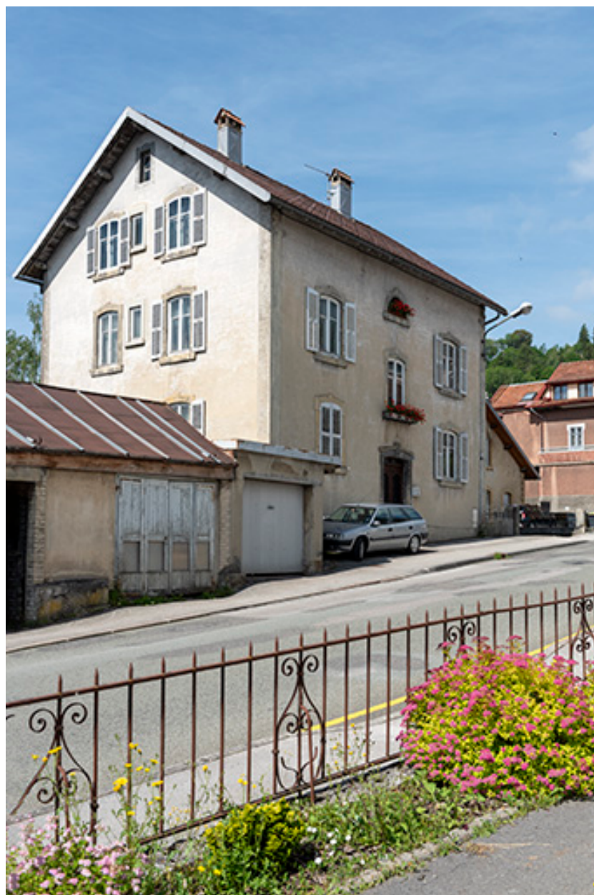
Façades latérale gauche et antérieure.
