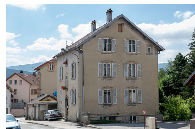
Façades latérale droite et antérieure. Phot. Sonia Dourlot IVR43_20182500978NUC4A
