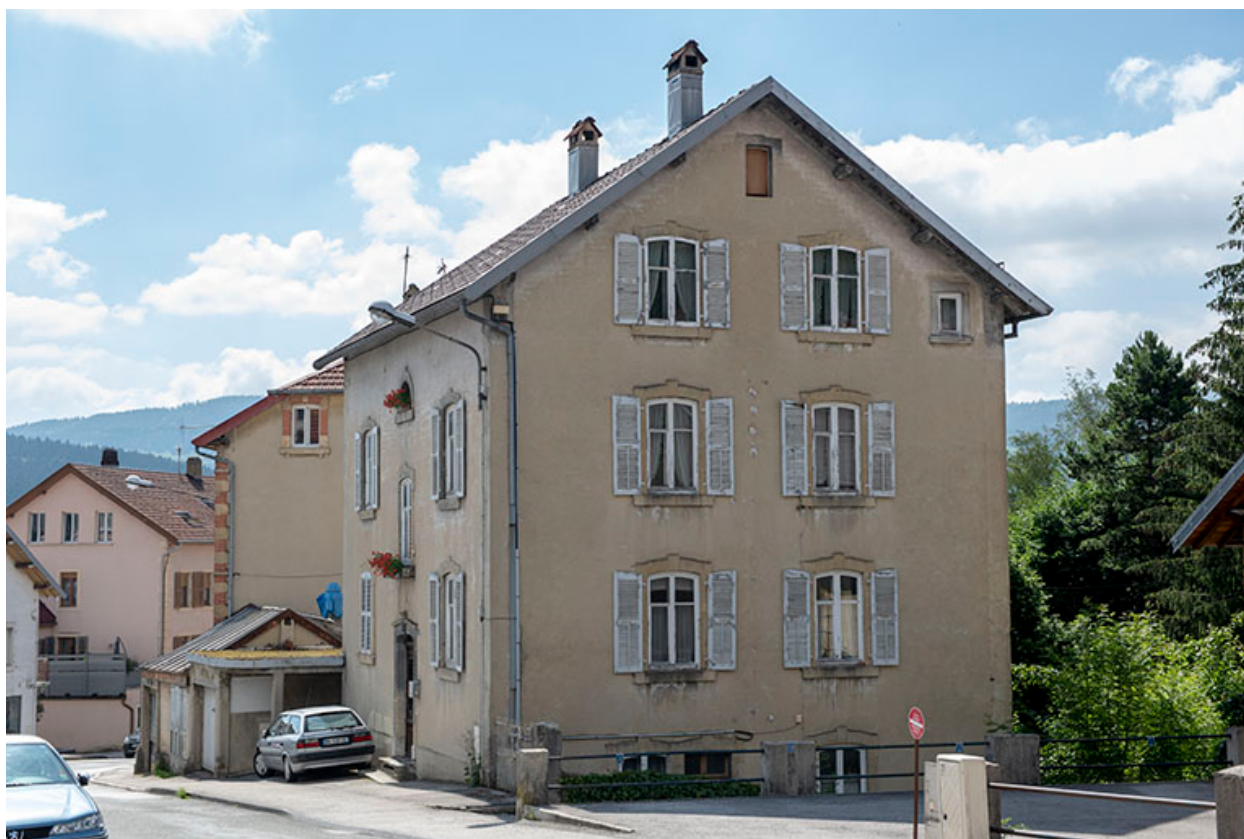
Façades latérale droite et antérieure.
