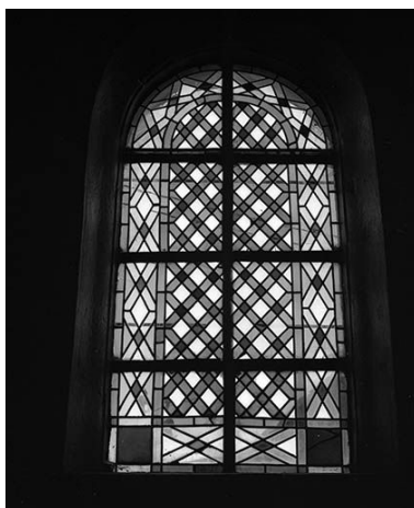
Baie n° 5. Phot. Jean-Luc Ligier IVR43_19822500326X
