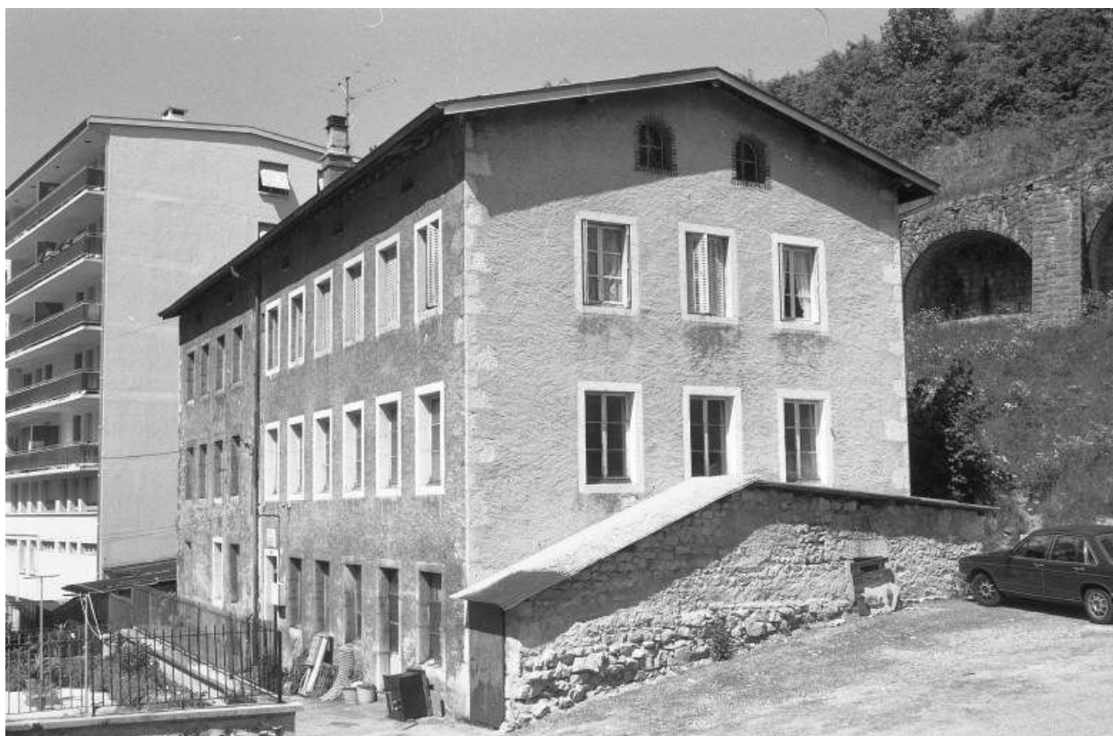
Façades antérieure et latérale droite.
