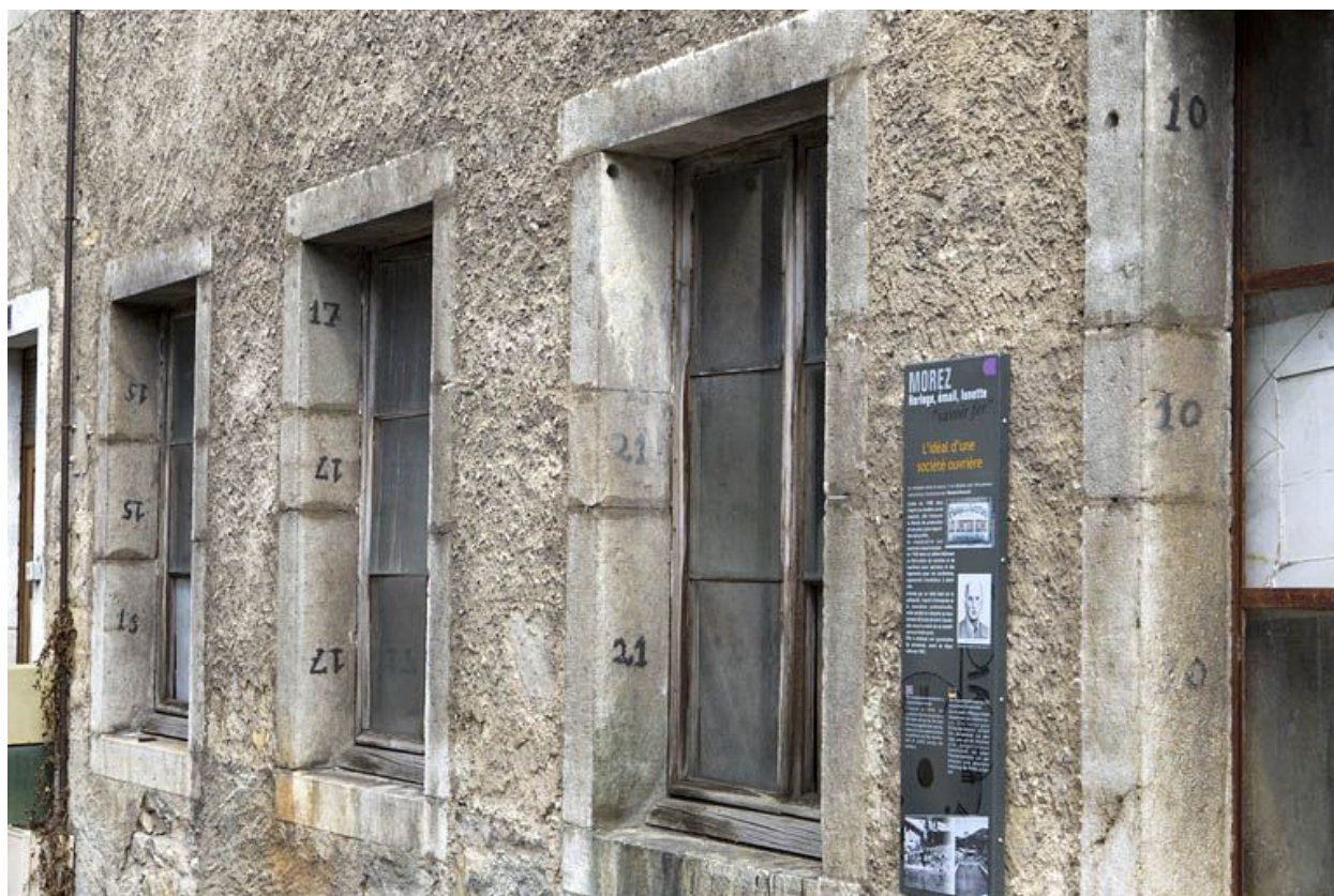
Chiffres peints sur les piédroits des fenêtres de la façade antérieure.
