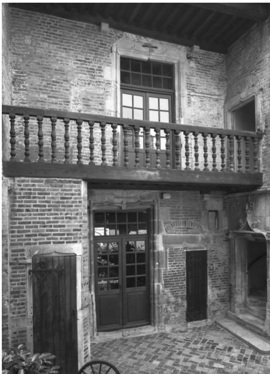
Corps principal, façade sur cour.
