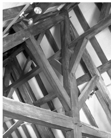
Charpente du niveau supérieur du comble. Phot. Michel Rosso IVR26_19862100857X
