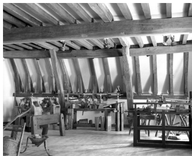
Charpente du niveau inférieur du comble. Phot. Michel Rosso IVR26_19862100856X
