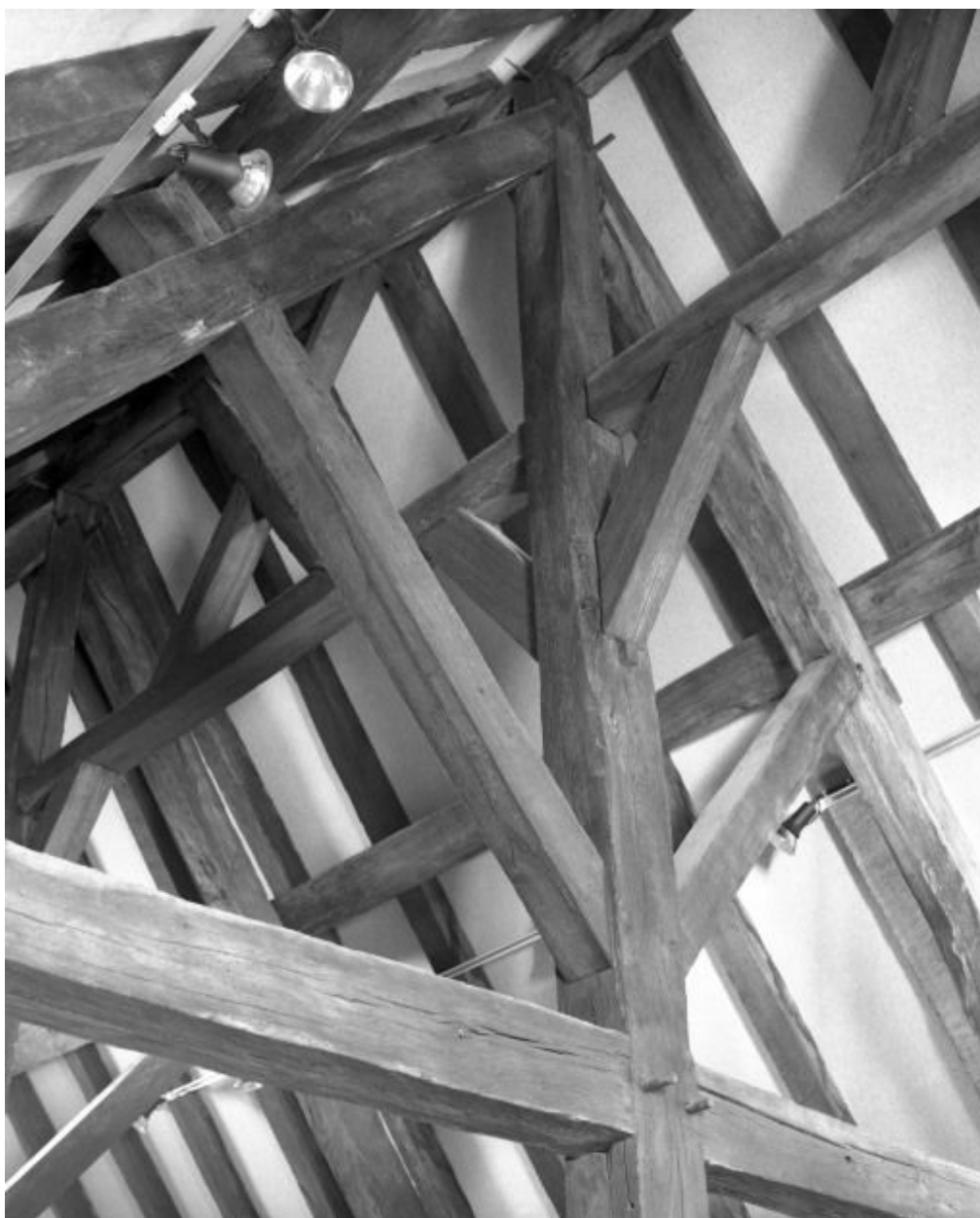
Charpente du niveau supérieur du comble.
