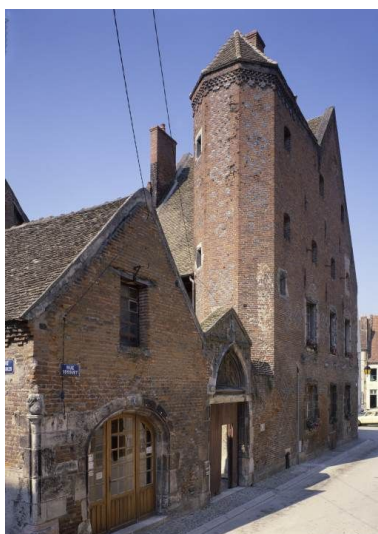
Façades sur la rue Bossuet. Phot. Michel Rosso IVR26_19862101583VA
