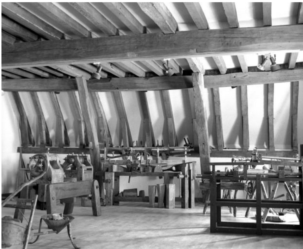
Charpente du niveau inférieur du comble.
