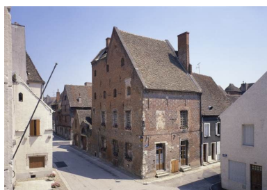
Vue d'ensemble. Phot. Michel Rosso IVR26_19862101585VA
