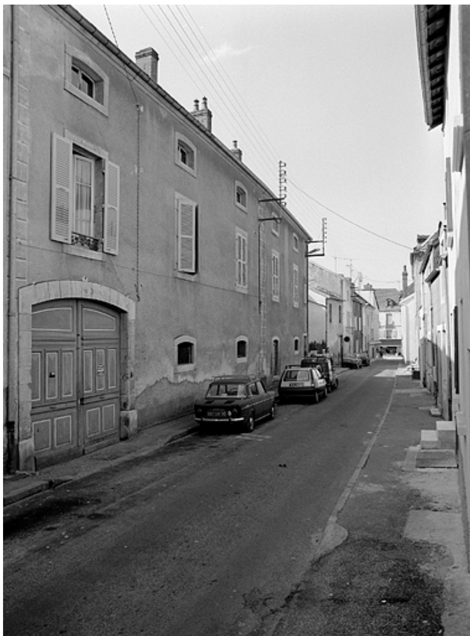
Façade antérieure de trois quarts gauche.
