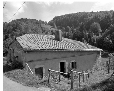
Face ouest. Phot. Jérôme Mongreville IVR43_19963901258X
