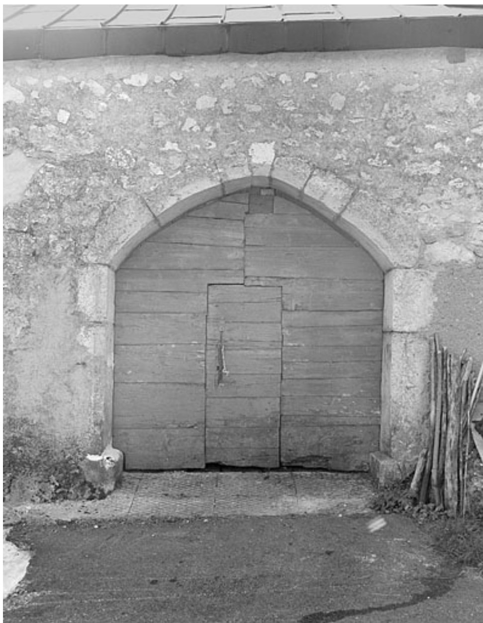
Porte de grange haute.
