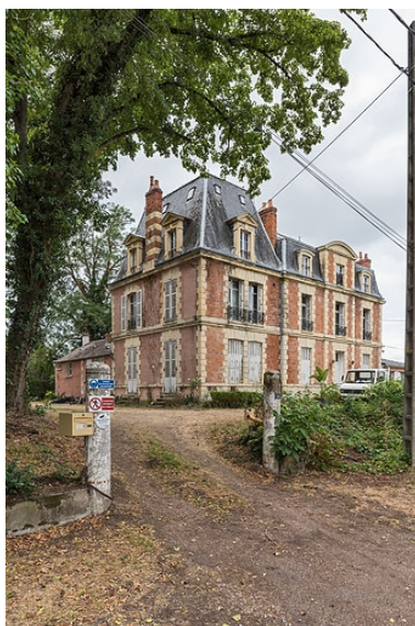
Vue d'ensemble depuis l'accès sur l'avenue de Paris. Phot. Pierre-Marie Barbe-Richaud IVR26_20205800426NUC4A
