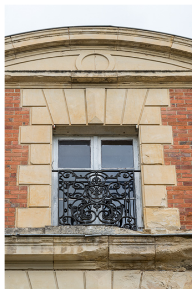
Façade sur l'avenue de Paris, détail, baie de la lucarne-pignon. Phot. Pierre-Marie Barbe-Richaud IVR26_20205800435NUC4A
