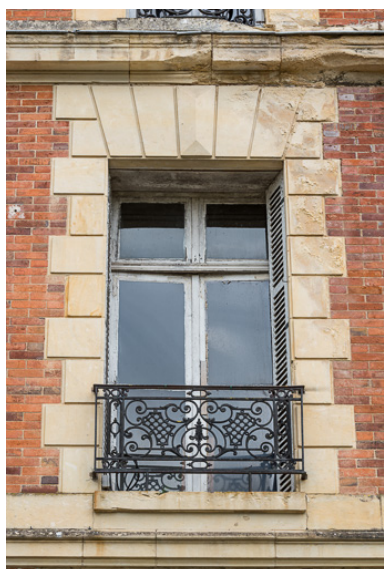
Façade sur l'avenue de Paris, détail, baie du premier étage. Phot. Pierre-Marie Barbe-Richaud IVR26_20205800434NUC4A
