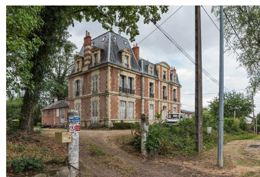
Vue d'ensemble depuis l'accès sur l'avenue de Paris. Phot. Pierre-Marie Barbe-Richaud IVR26_20205800427NUC4A
