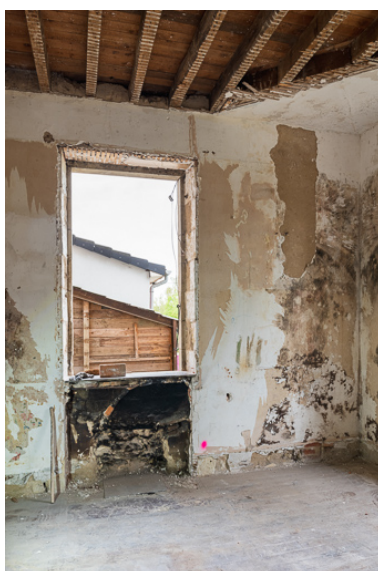
Salon au rez-de-chaussée avec vestige d'une cheminée sous baie. Phot. Pierre-Marie Barbe-Richaud IVR26_20205800436NUC4A
