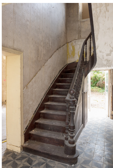
Escalier du corps principal, rez-de-chaussée. Phot. Pierre-Marie Barbe-Richaud IVR26_20205800438NUC4A
