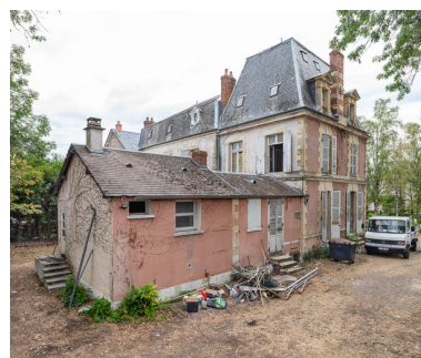
Extension à l'arrière du pavillon sud. Phot. Pierre-Marie Barbe-Richaud IVR26_20205800431NUC4A
