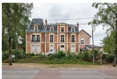
Façade sur l'avenue de Paris, vue de face. Phot. Pierre-Marie Barbe-Richaud IVR26_20205800428NUC4A
