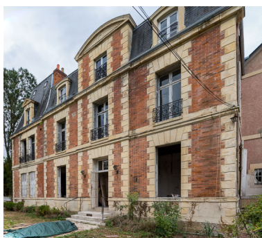
Façade sur l'avenue de Paris, vue de trois-quarts depuis le nord. Phot. Pierre-Marie Barbe-Richaud IVR26_20205800433NUC4AQ
