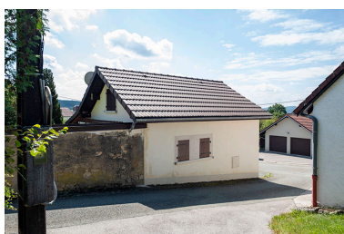
Nouvelle forge : façades
