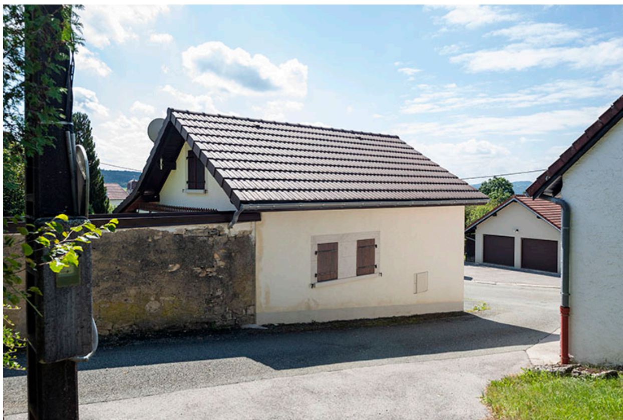
Nouvelle forge : façades postérieure et latérale gauche.
