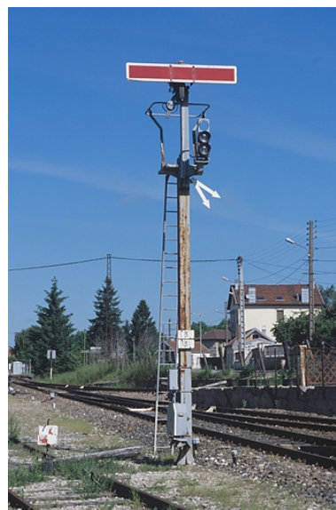
Sémaphore côté Andelot-en-Montagne : vue d'ensemble, en position fermée. Phot. Yves Sancey IVR43_20053900070ZA
