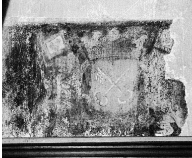
Vue d'ensemble. Phot. Jean-Luc Duthu IVR26_19782101400X
