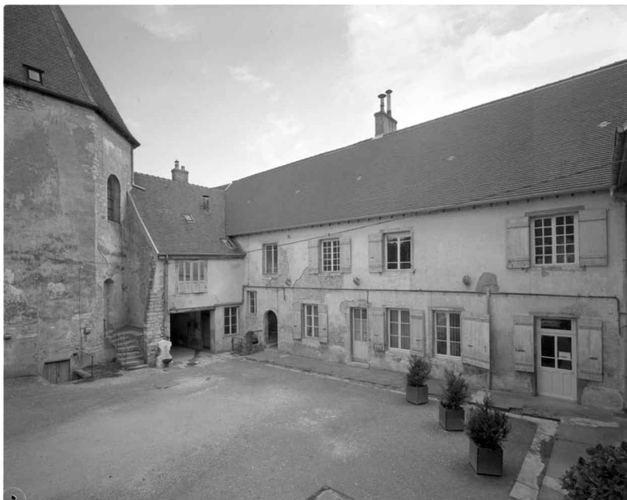
Bâtiment sur cour : aile gauche.
