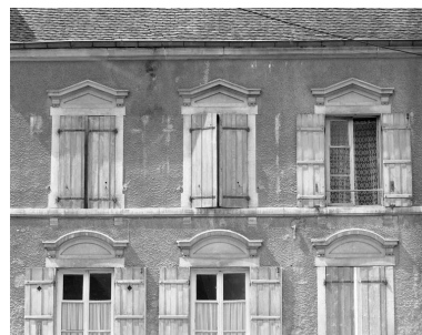
Façade sur rue : détail des baies. Phot. Yves Sancey IVR43_19897000436X
