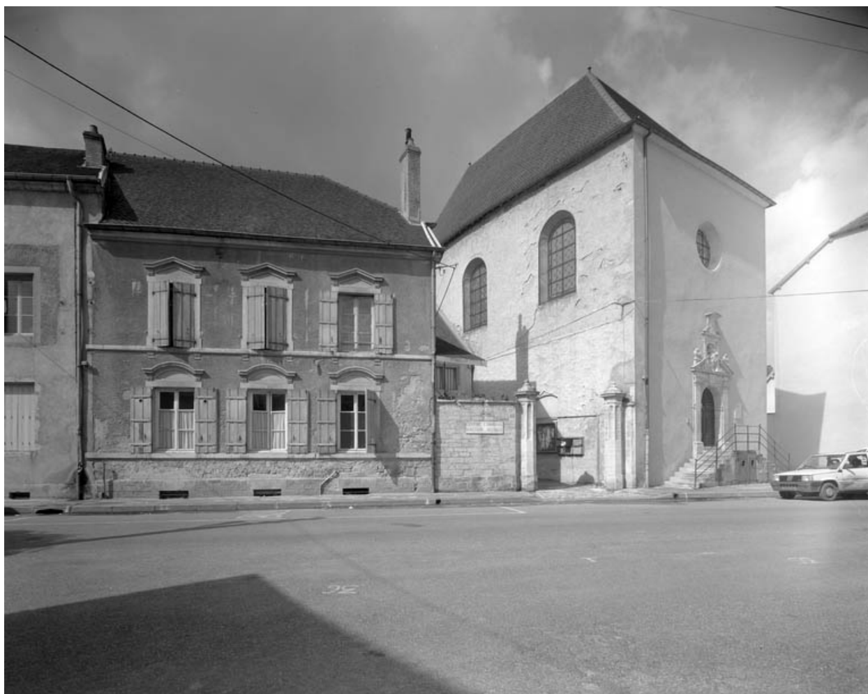
Vue d'ensemble depuis la rue.
