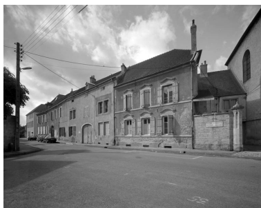
Façade sur rue : partie gauche. Phot. Yves Sancey IVR43_19897000435V
