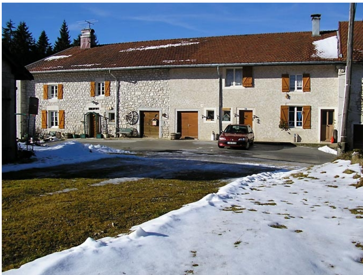
Ferme située au lieu-dit Les Frasses en Bas.
