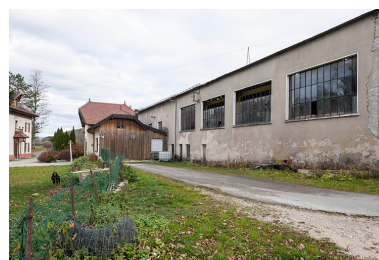
Atelier de scierie. Phot. Jérôme Mongreville IVR43_20152502505NUC4A
