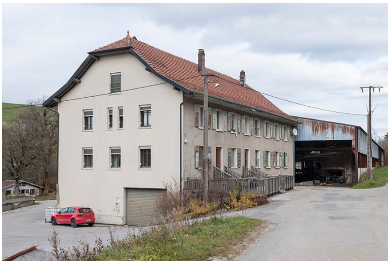
Bâtiment des logements et du bureau.
