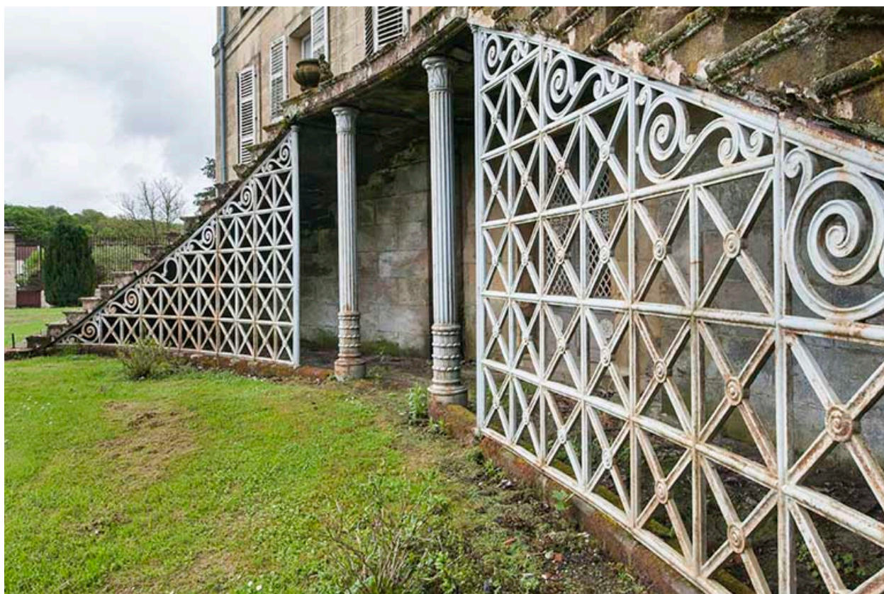
Structure métallique soutenant l'escalier.
