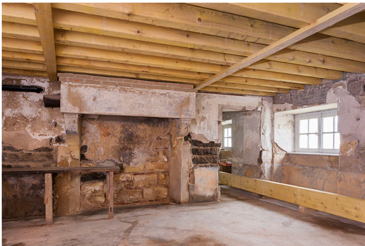
La cuisine du sous-sol et sa cheminée.
