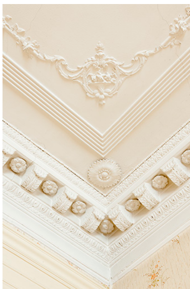
Détail du décor du plafond. Phot. Jérôme Mongreville IVR43_20167000862NUC4A
