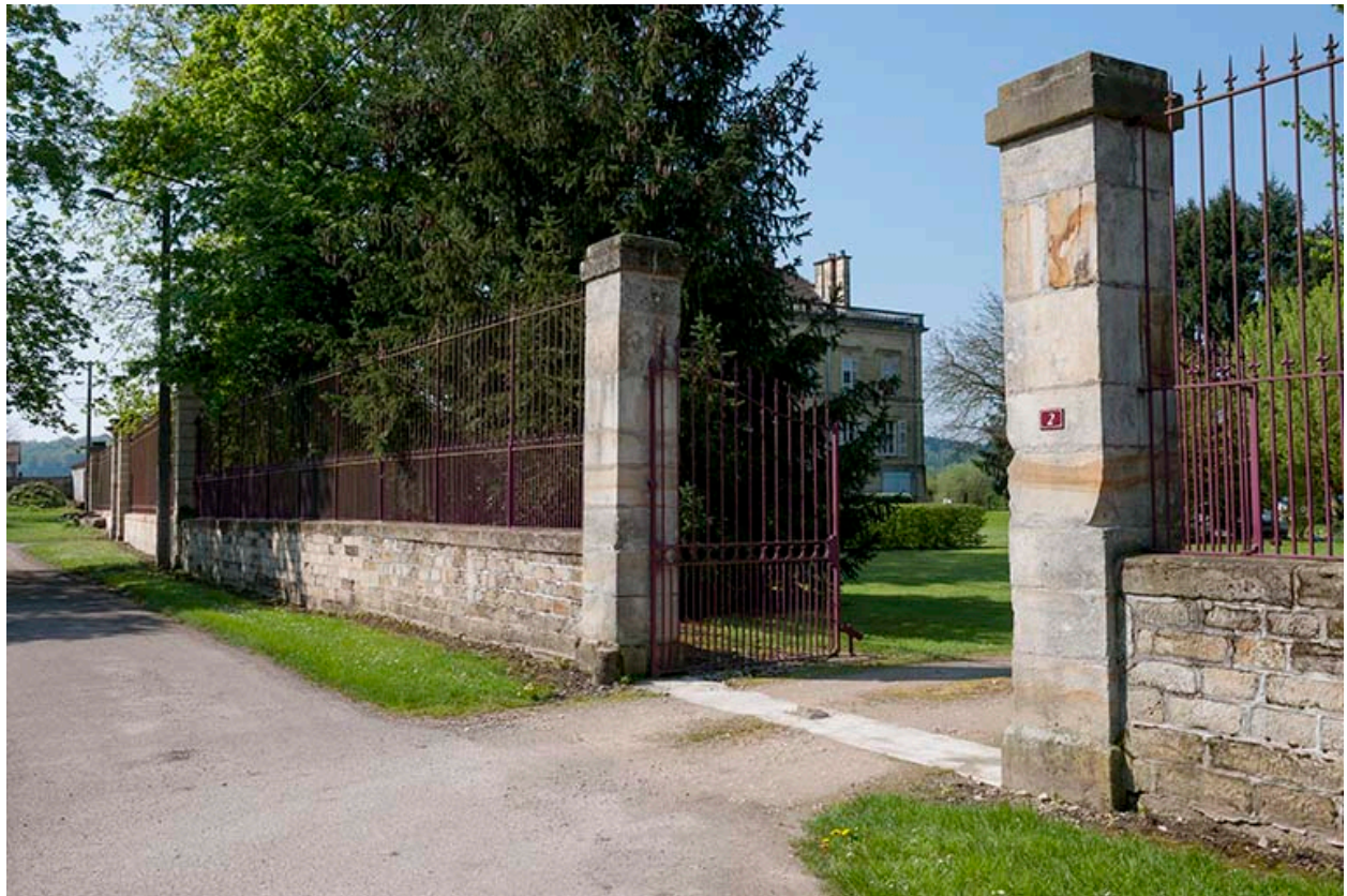
Portail d'accès aux parties agricoles.
