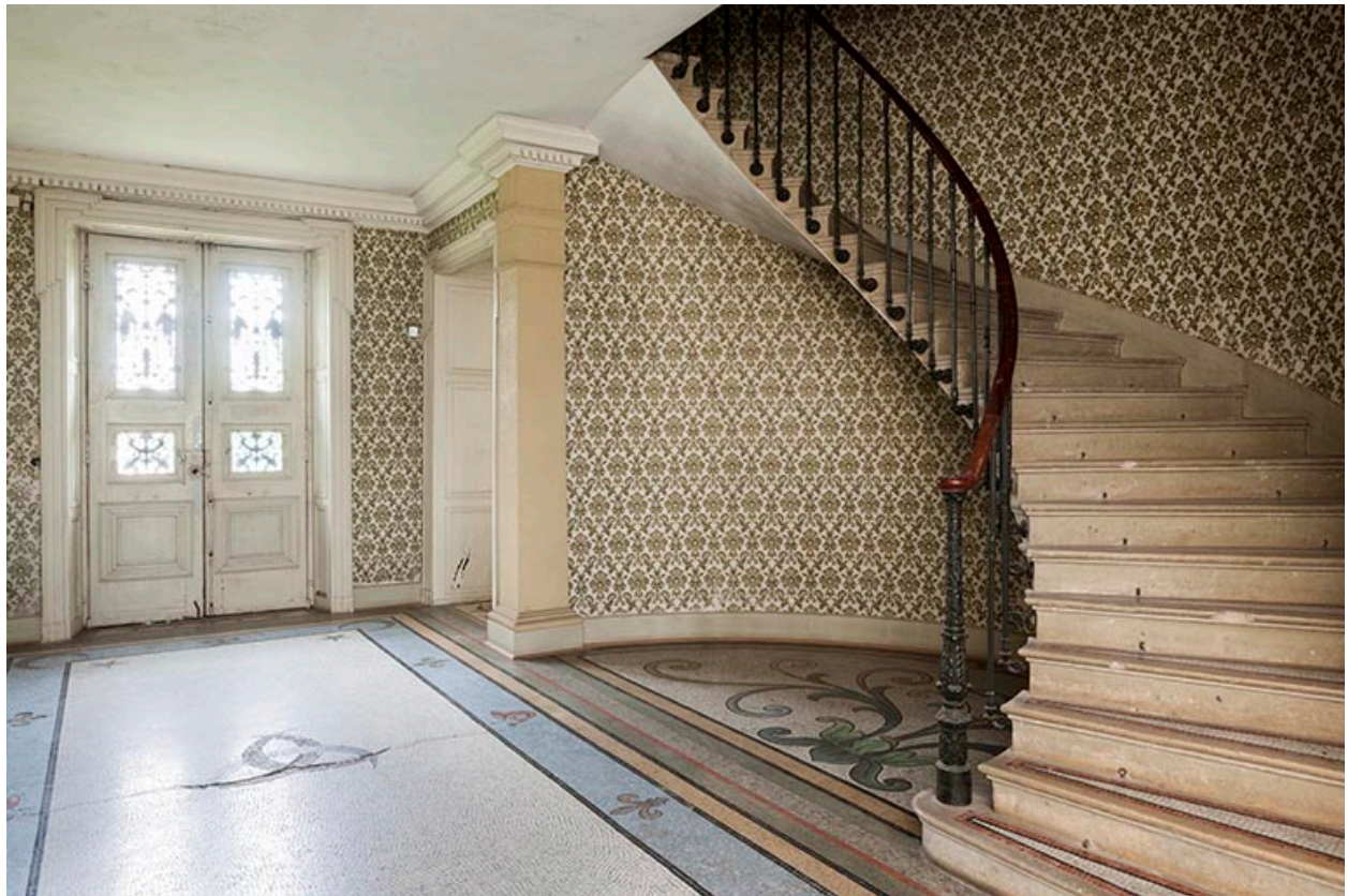
L'escalier en vis suspendu.
