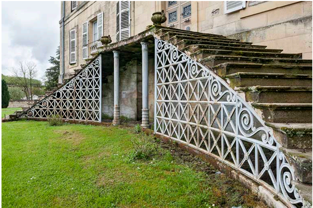
L'escalier double, façade nord.
