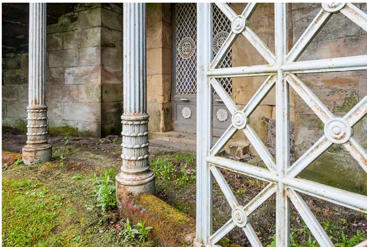
Détail sur l'armature métallique.
