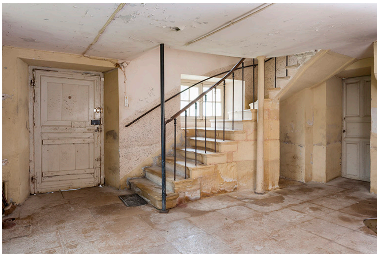
Escalier d'accès au rez-de-chaussée depuis le sous-sol.
