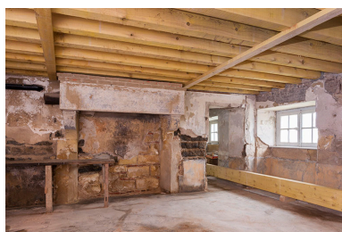
La cuisine du sous-sol et sa cheminée. Phot. Jérôme Mongreville IVR43_20167000840NUC4A
