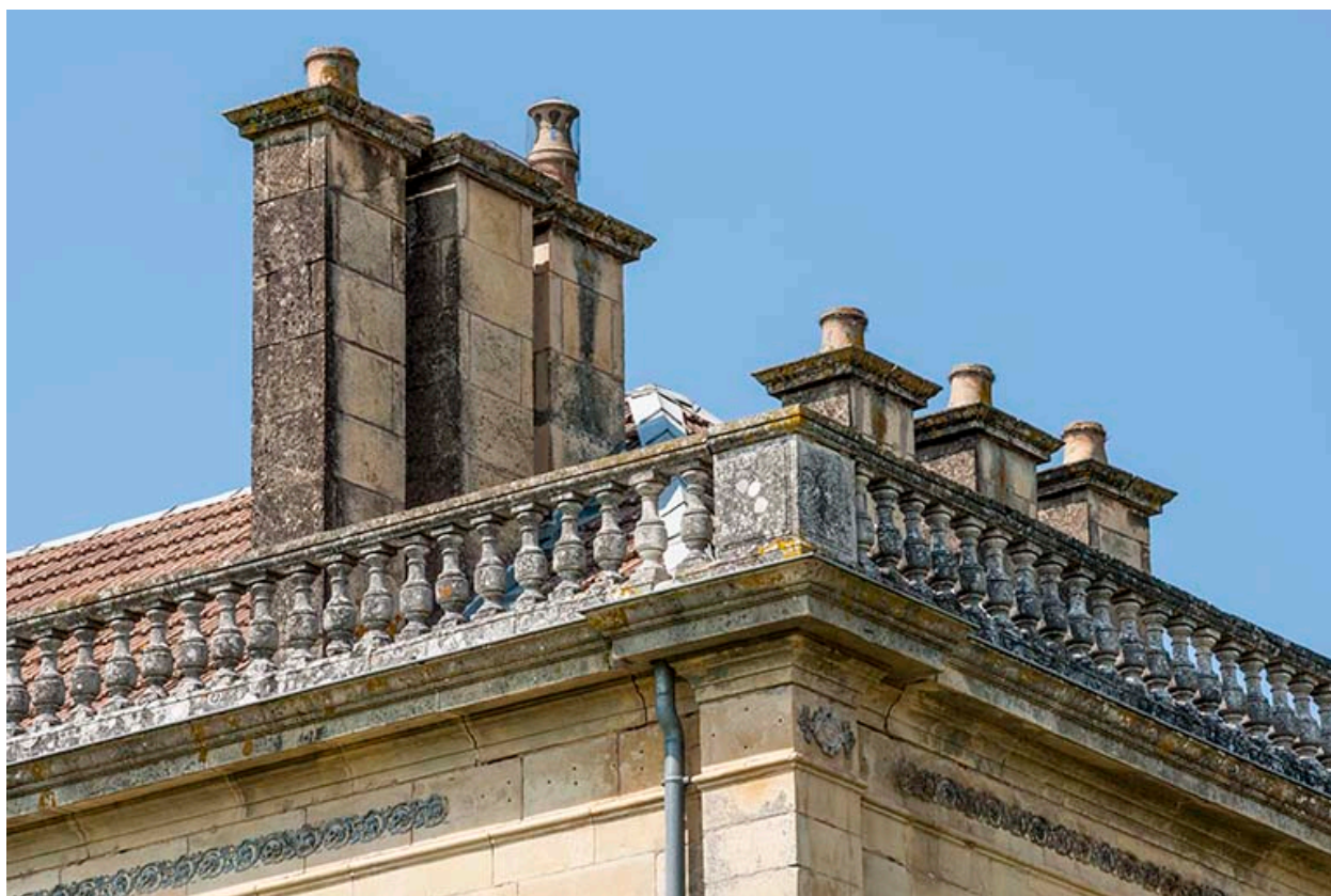
Balustrades et souches de cheminées.
