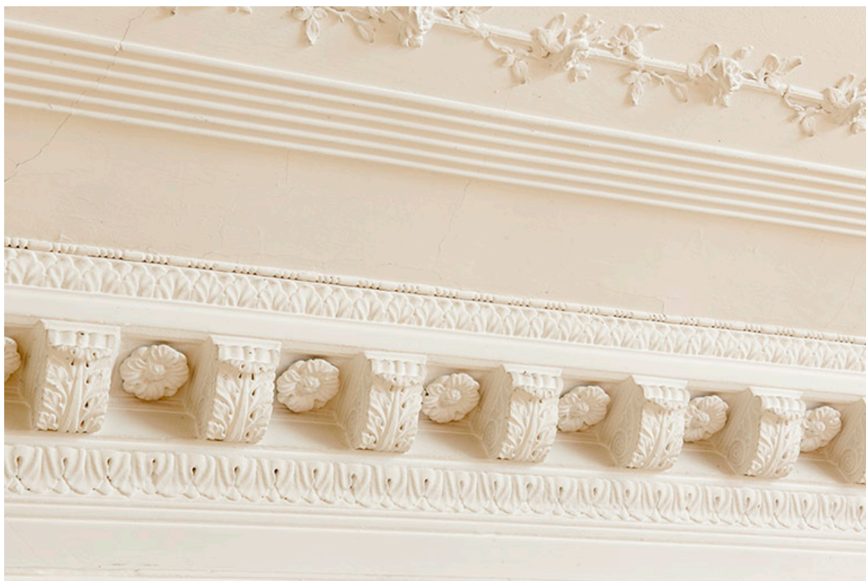
Détail de la corniche du plafond.
