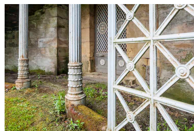
Détail sur l'armature métallique. Phot. Jérôme Mongreville IVR43_20167000872NUC4A
