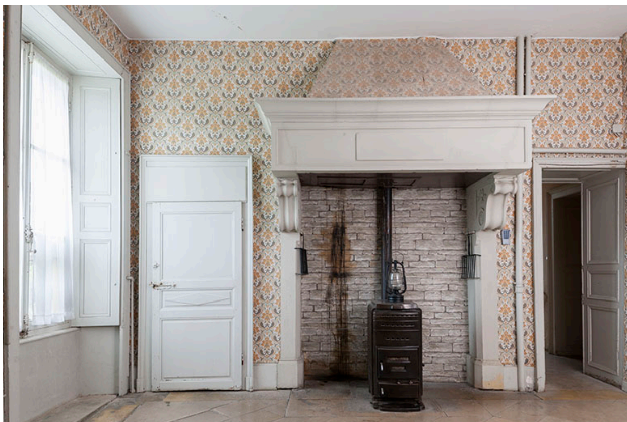
Cheminée de l'ancienne cusiine du rez-de-chaussée.
