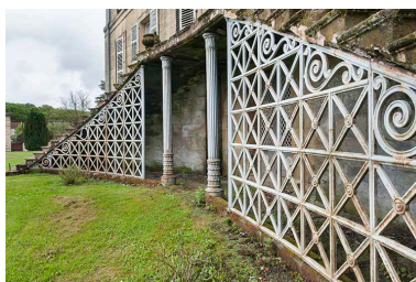
Structure métallique soutenant l'escalier. Phot. Jérôme Mongreville IVR43_20167000871NUC4A
