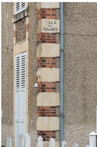
Chaîne d'angle portant le nom ("Villa Les Nontaies"). Phot. Pierre-Marie Barbe-Richaud IVR26_20205800461NUC4A
