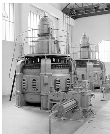
Régulateur, pivoterie et alternateur de 2 groupes. Phot. Jérôme Mongreville IVR43_19923900523X
