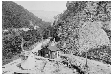
Attaque n° 4. Sortie aval du grand souterrain de 1750 m à Porte-Sachet. Poste de transformation et compression d'air n° 3. Phot. Jérôme Mongreville, Phot. Jules Debachy IVR43_19923900314X
