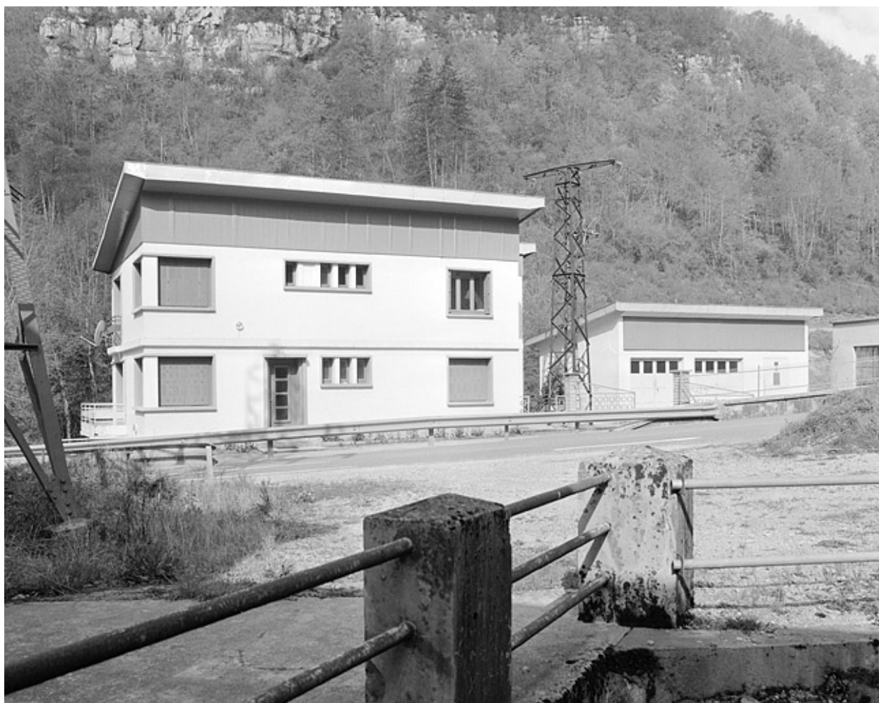
Logement d'ouvriers et remise d'automobile.
