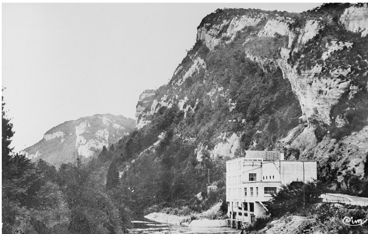
Chassal (Jura). Centrale électrique de St-Claude.
