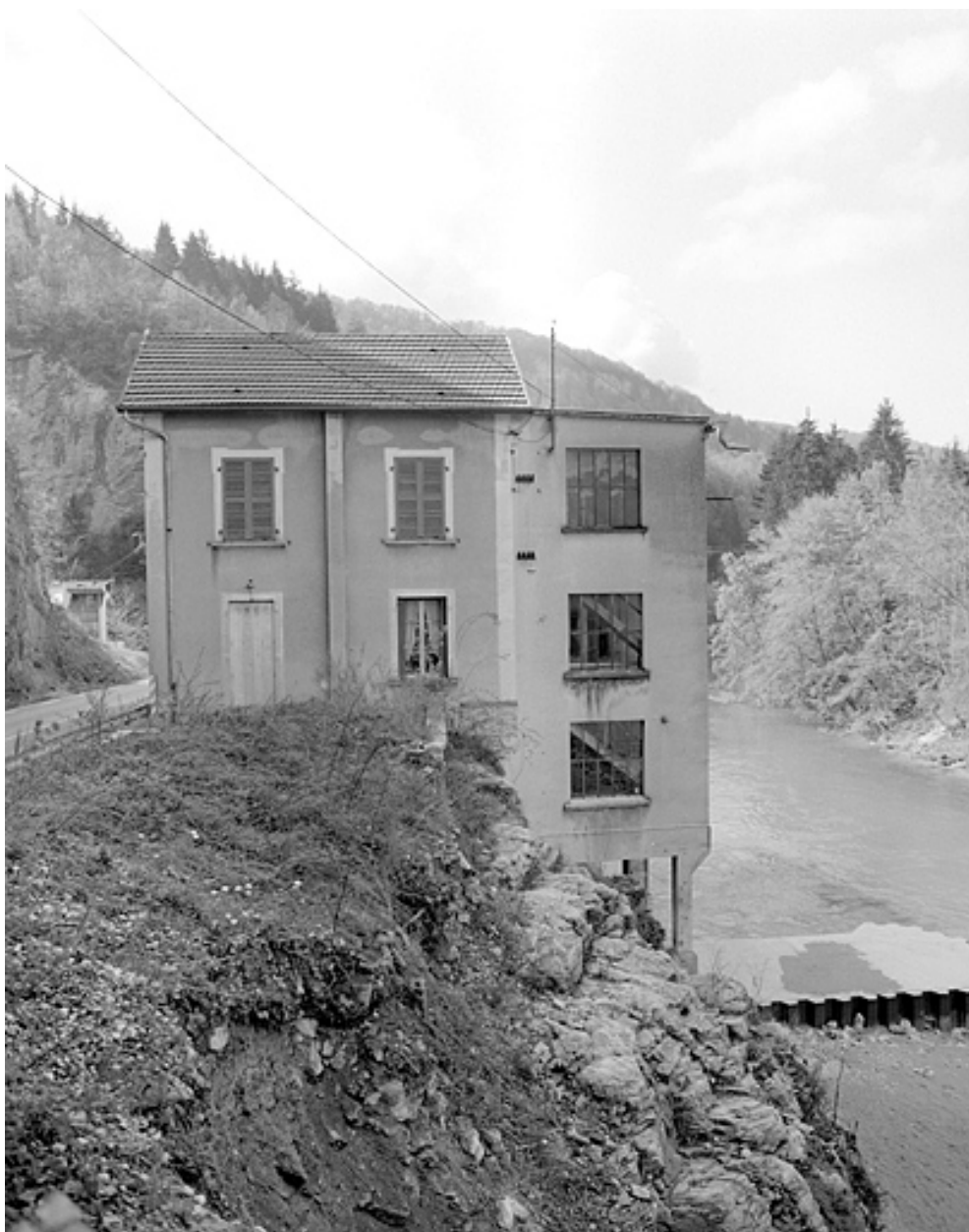
Façade postérieure de la centrale.
