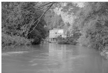
Vue d'ensemble, depuis l'aval. Phot. Laurent Poupard IVR43_19913901160Z
