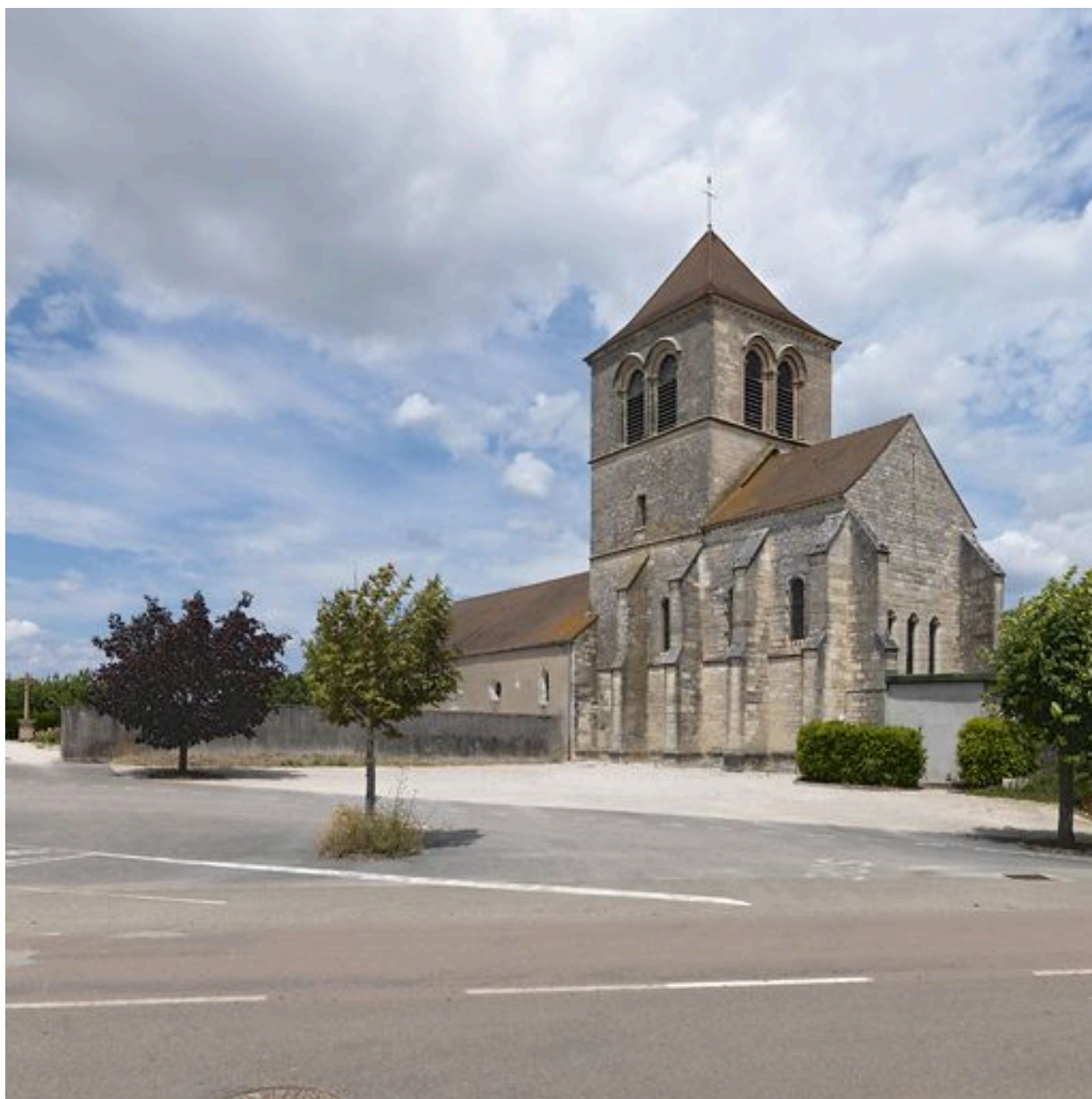
Eglise Saint-Pierre : vue d'ensemble.
