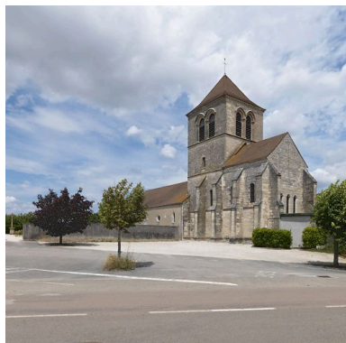
Eglise Saint-Pierre : vue d'ensemble.
