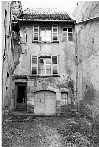
Façade antérieure sur cour.
