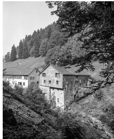
Vue d'ensemble, depuis le nord-est, en 1976. Phot. Dominique Humbert IVR43_19762500350X
