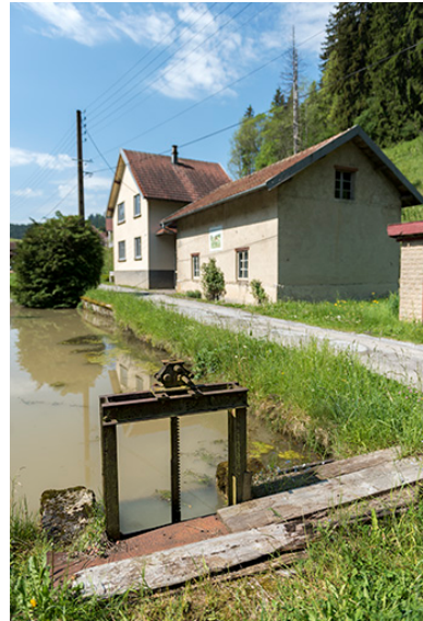
Vanne de prise d'eau, remise et maison.
