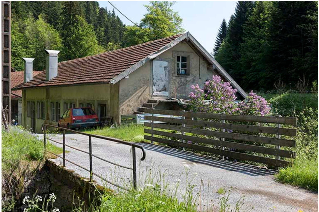
Usine : façades antérieure et latérale droite.
