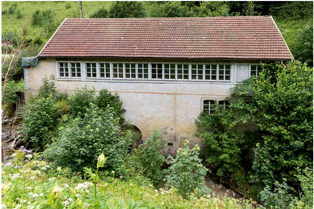
Usine : façade postérieure.
