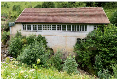
Usine : façade postérieure.
