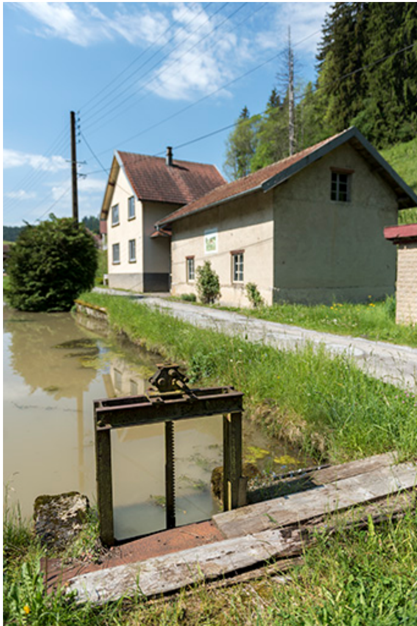
Vanne de prise d'eau, remise et maison.
