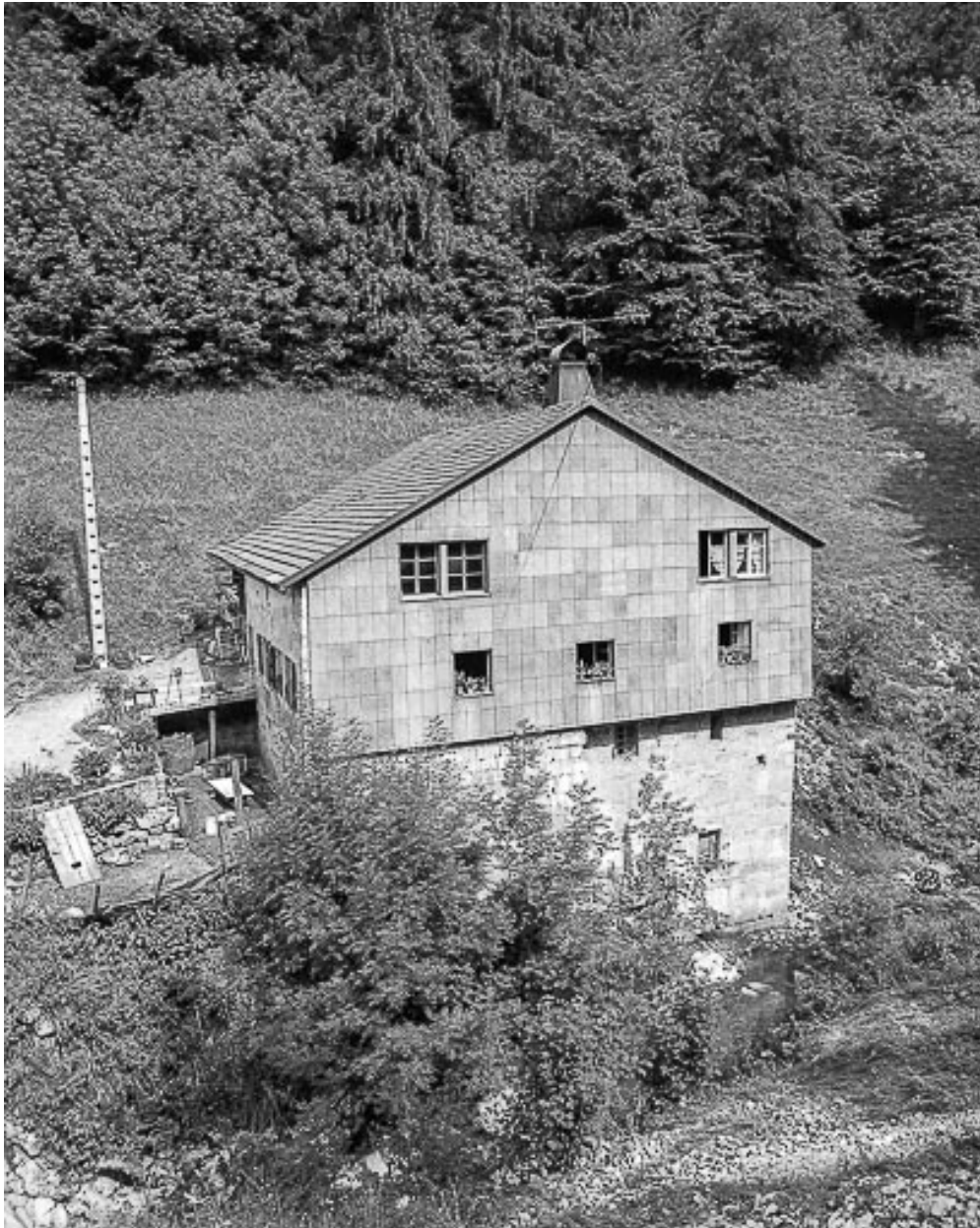
Ancien moulin : façade latérale droite, en 1976.
