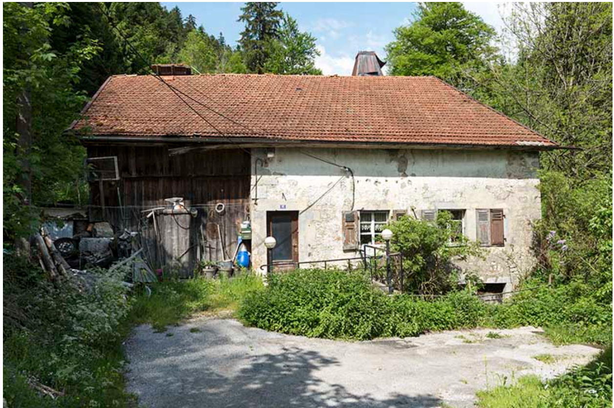
Ancien moulin : façade antérieure.
