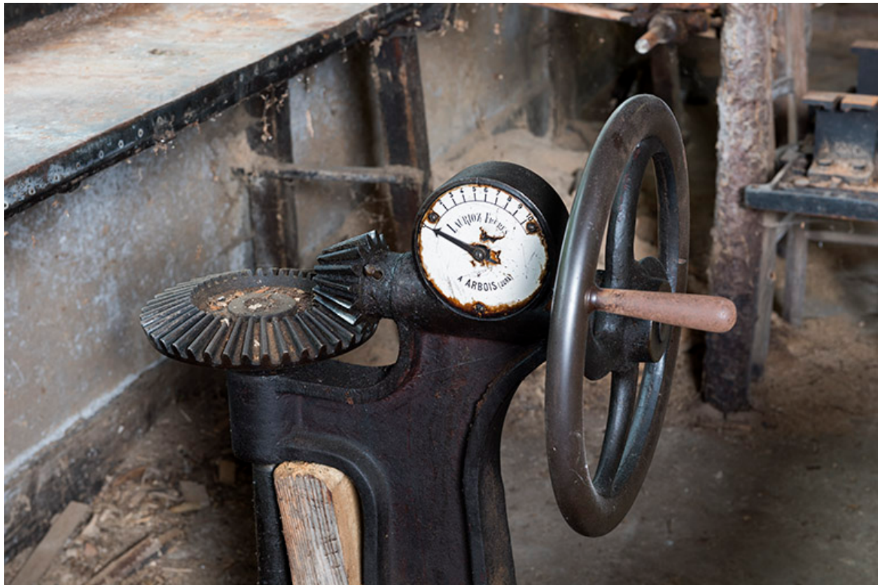
Usine : commande de la turbine Laurioz.
