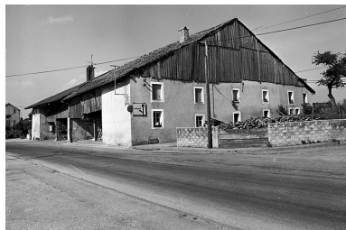
Vue de trois quarts. Phot. Dominique Dominguez IVR43_19792500840X
