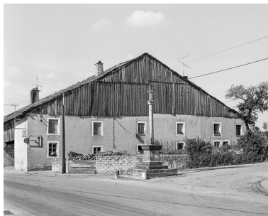
Pignon d'habitation. Phot. Dominique Dominguez IVR43_19792500841X
