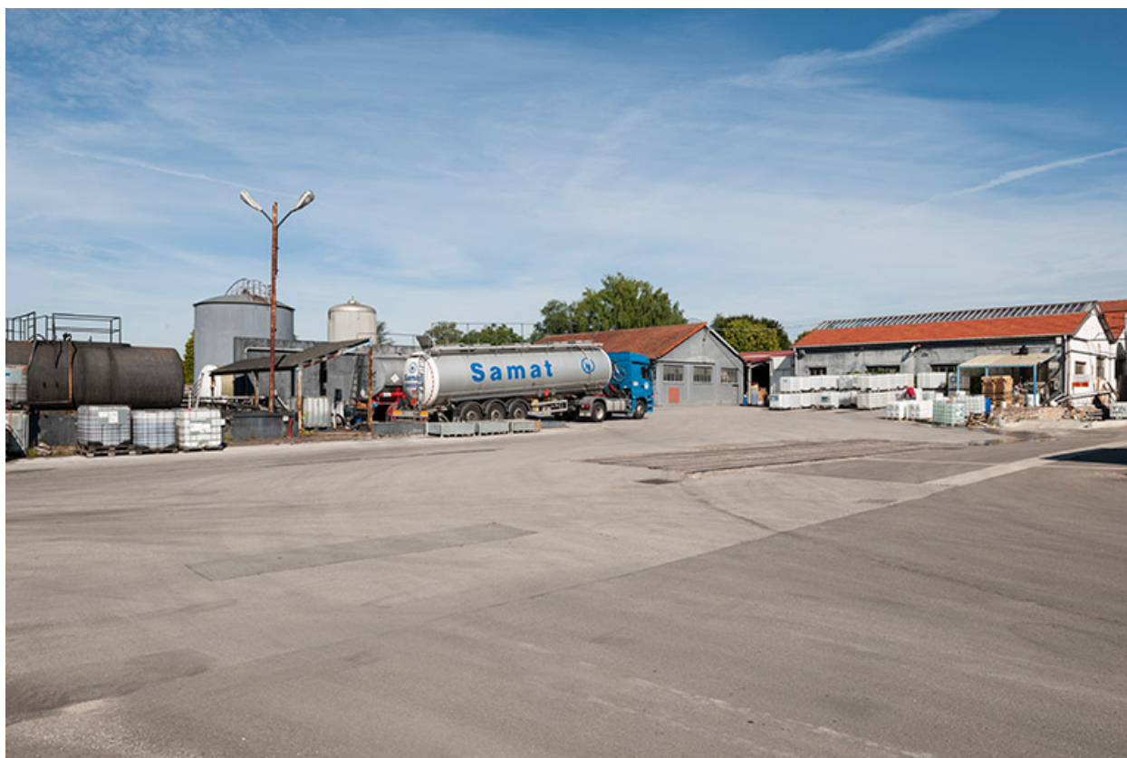
Vue d'ensemble depuis la cour, au sud-est.
