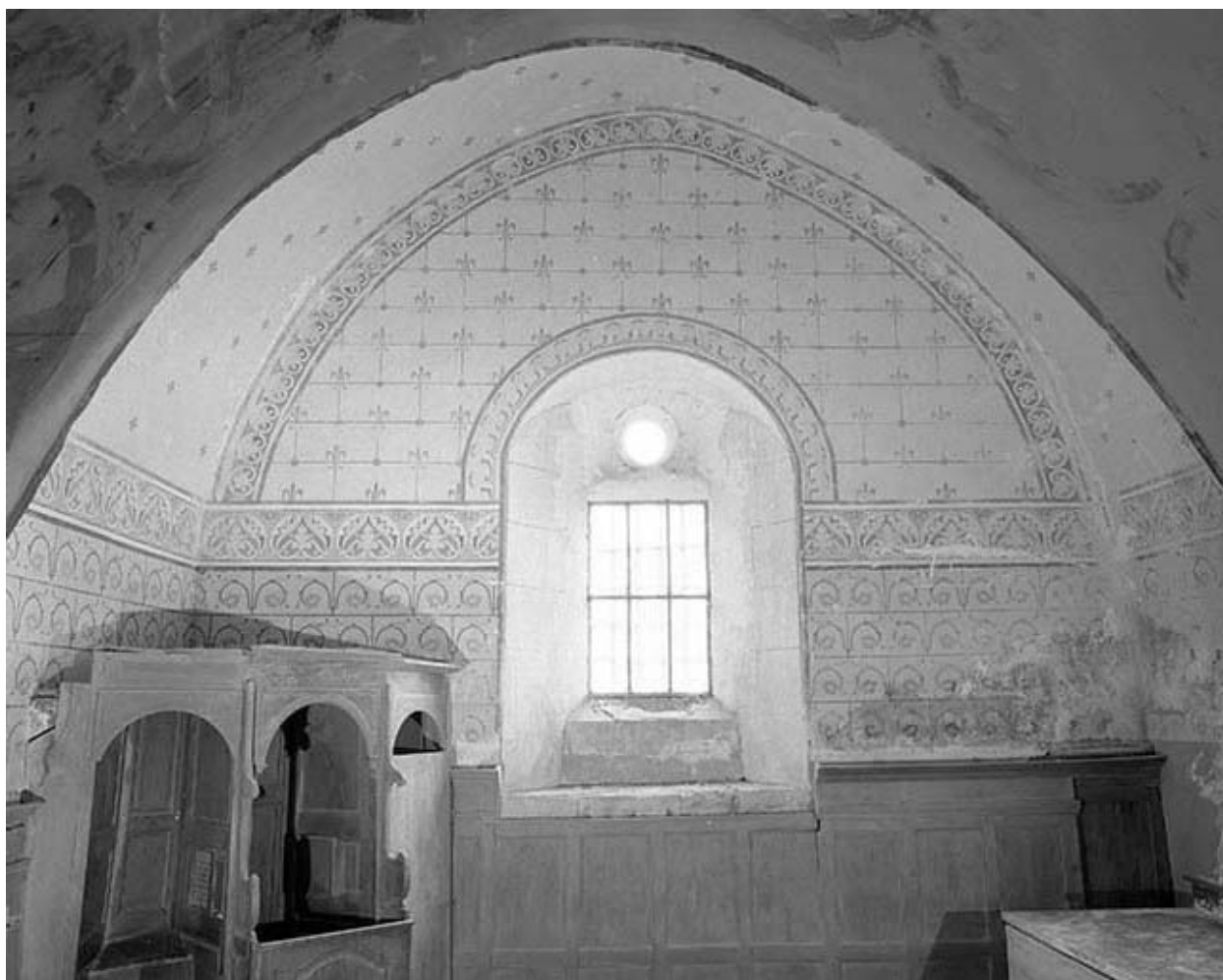
Intérieur : première chapelle gauche.
