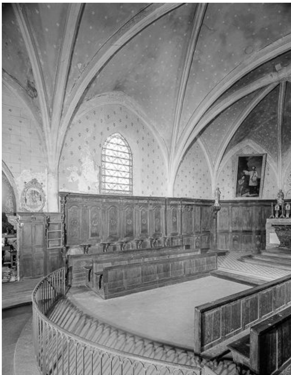
Intérieur : chœur, mur gauche.
