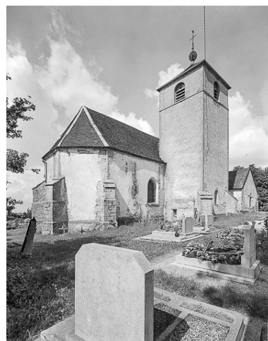
Façade latérale gauche vue depuis l'est.
