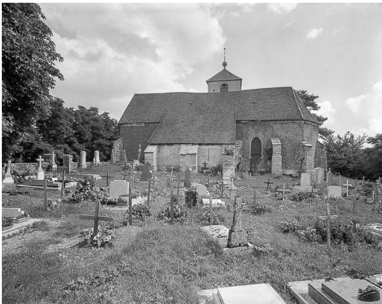
Façade latérale droite.
