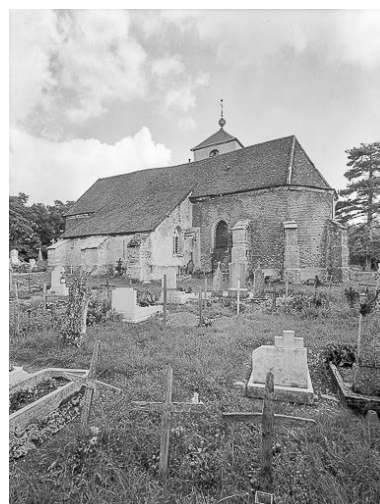
Façade latérale droite vue depuis l'est. Phot. Yves Sancey IVR43_19743901223V
