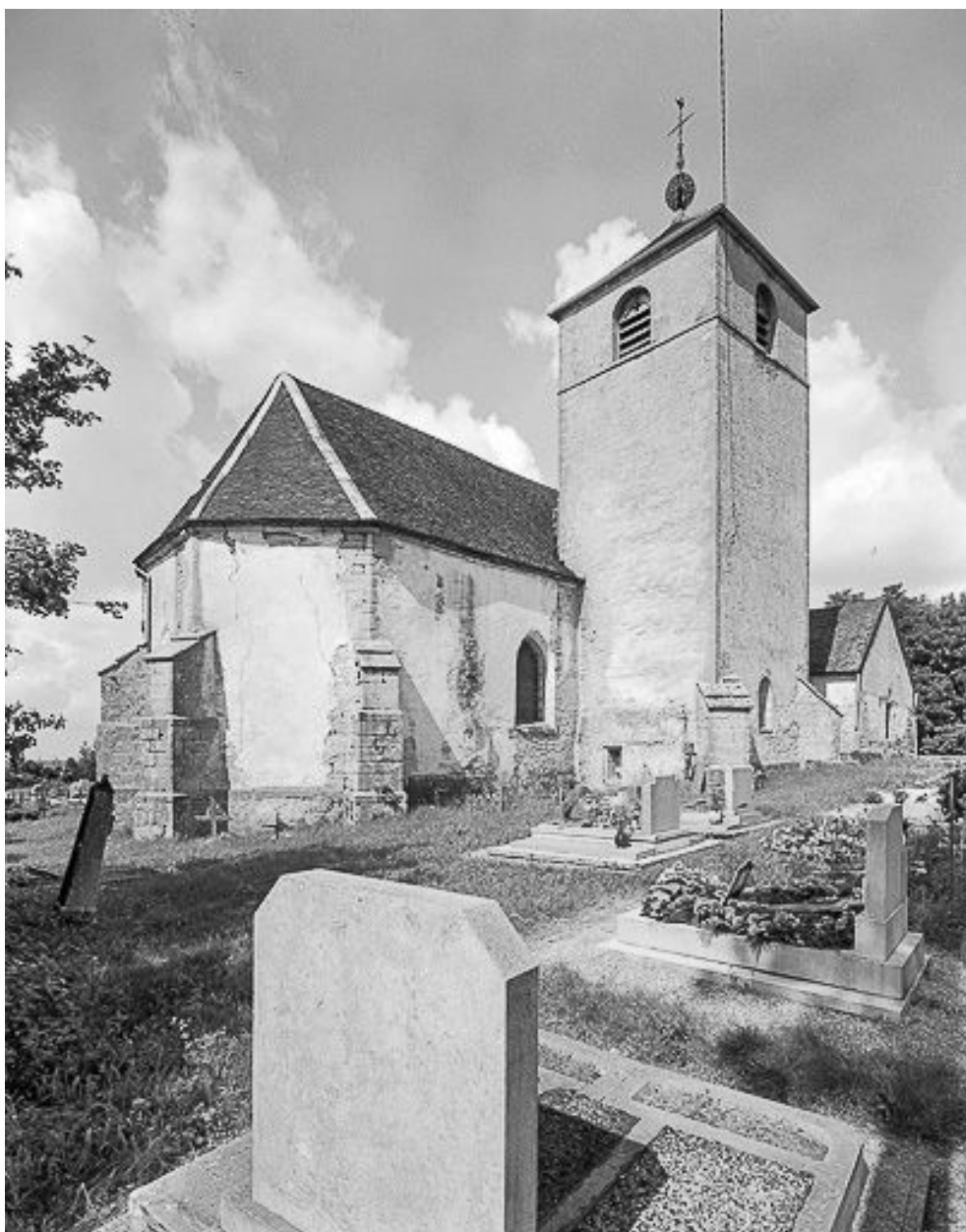
Façade latérale gauche vue depuis l'est.
