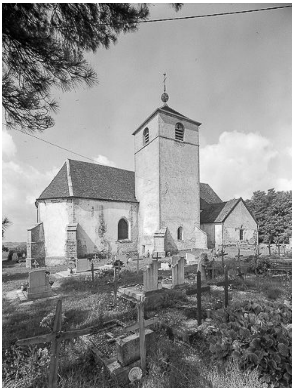
Façade latérale gauche : vue de trois quarts.
