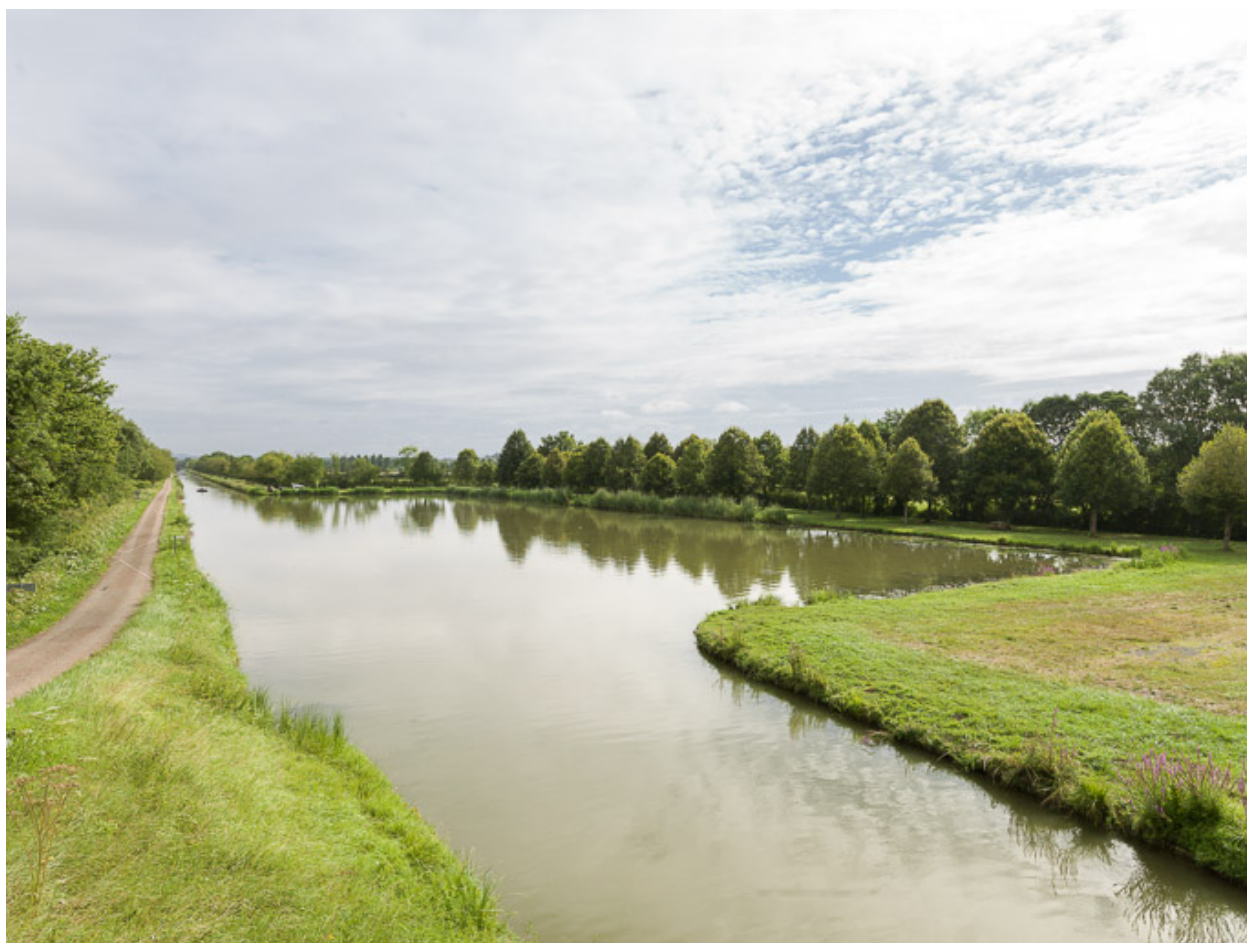
Vue d'ensemble du port.
