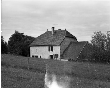
Façade postérieure. Phot. Yves Sancey IVR43_19813900257X
