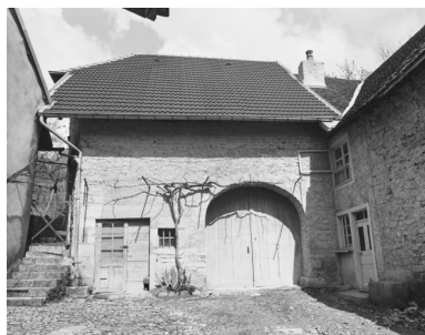
Ferme située rue du Dessous. Phot. Dominique Dominguez IVR43_19783900147X
