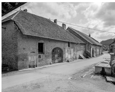
Fermes situées rue du Dessous. Phot. Dominique Dominguez IVR43_19783900151X
