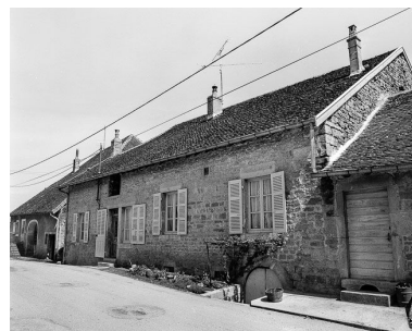
Fermes situées rue du Dessous. Phot. Dominique Dominguez IVR43_19783900150X
