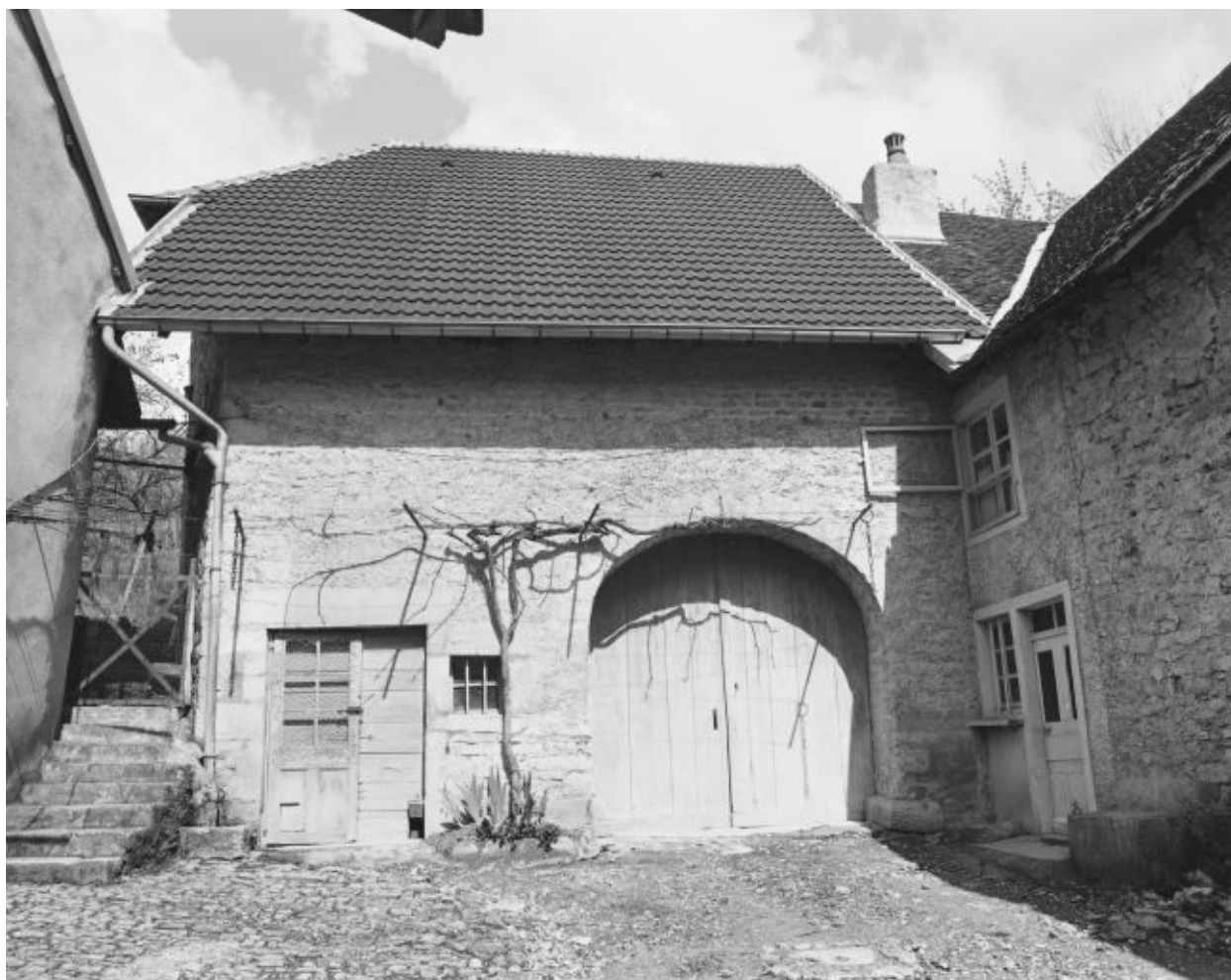
Ferme située rue du Dessus.
