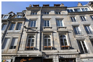
Détail de la façade sur rue au-dessus du rez-de-chaussée, de face. Phot. Yves Sancey IVR43_20082500286NUC2A
