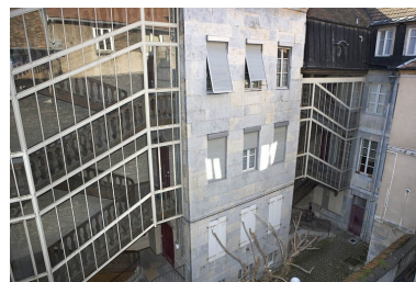
Bâtiment à gauche de la première cour : vue rapprochée. Phot. Yves Sancey IVR43_20082500294NUC2A
