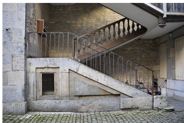
Détail du départ du premier escalier à cage ouverte depuis la cour. Phot. Yves Sancey IVR43_20082500288NUC2A
