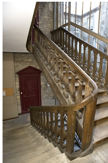
Détail du premier escalier à cage ouverte depuis l'intérieur de la cage. Phot. Yves Sancey IVR43_20082500287NUC2A
