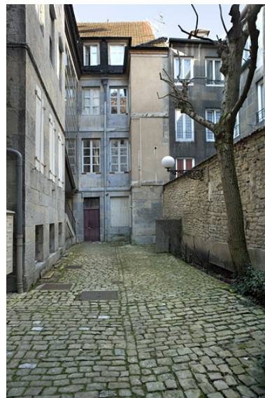
Vue d'ensemble de la façade antérieure du logis secondaire. Phot. Yves Sancey IVR43_20082500290NUC2A
