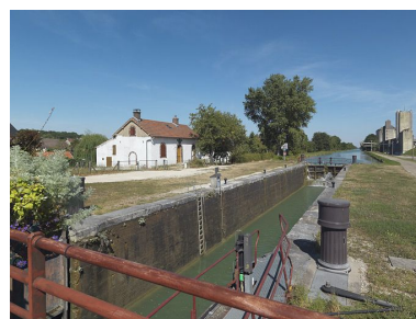
Panorama du site d'écluse pris d'aval, du pont sur écluse. De gauche à droite : site d'écluse, silos. Le bief est vide : on voit la maçonnerie des bajoyers.
