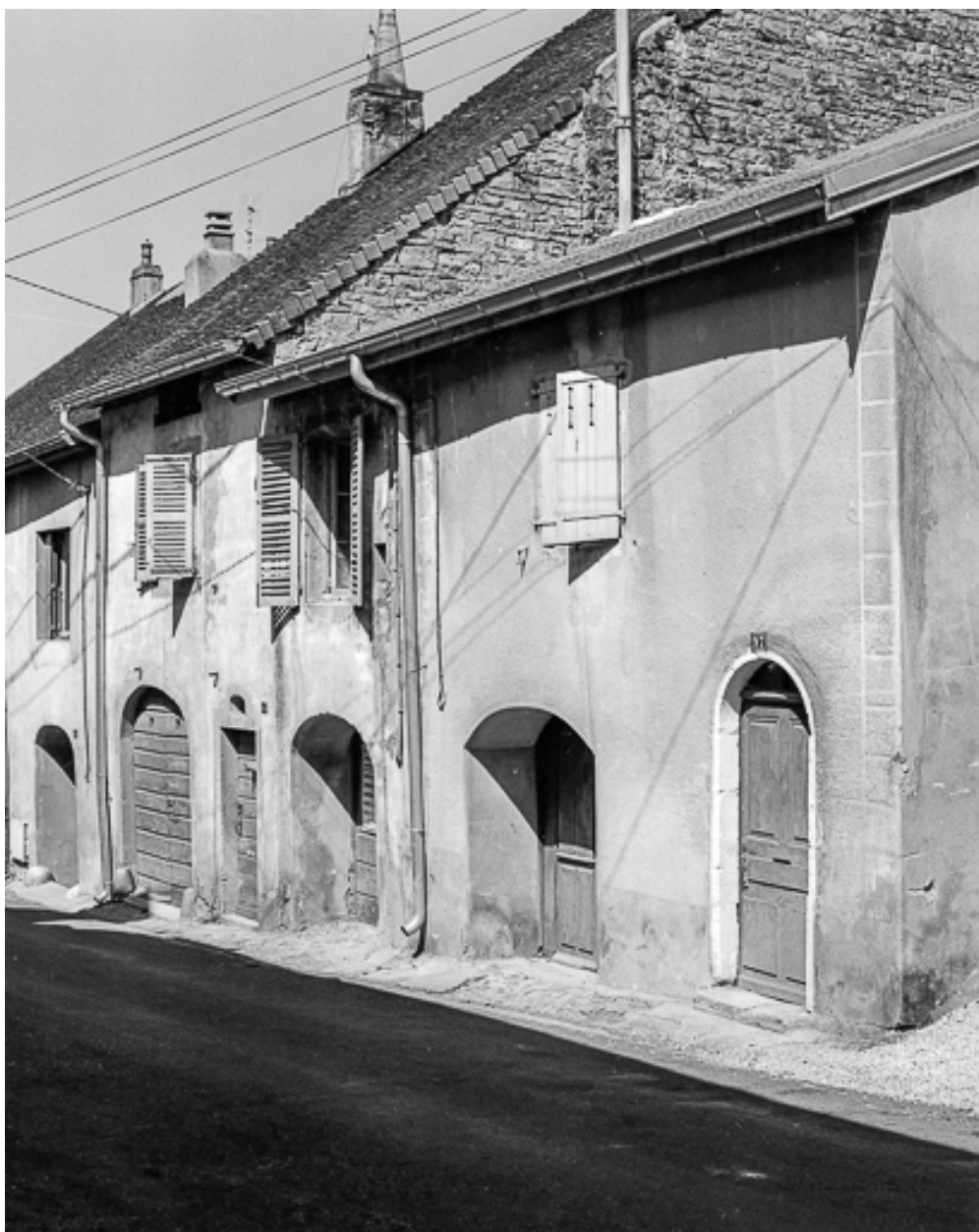
Maisons : façades sur rue.
