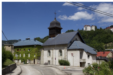
Façade latérale droite. Phot. Yves Sancey IVR43_20103900405NUC2A
