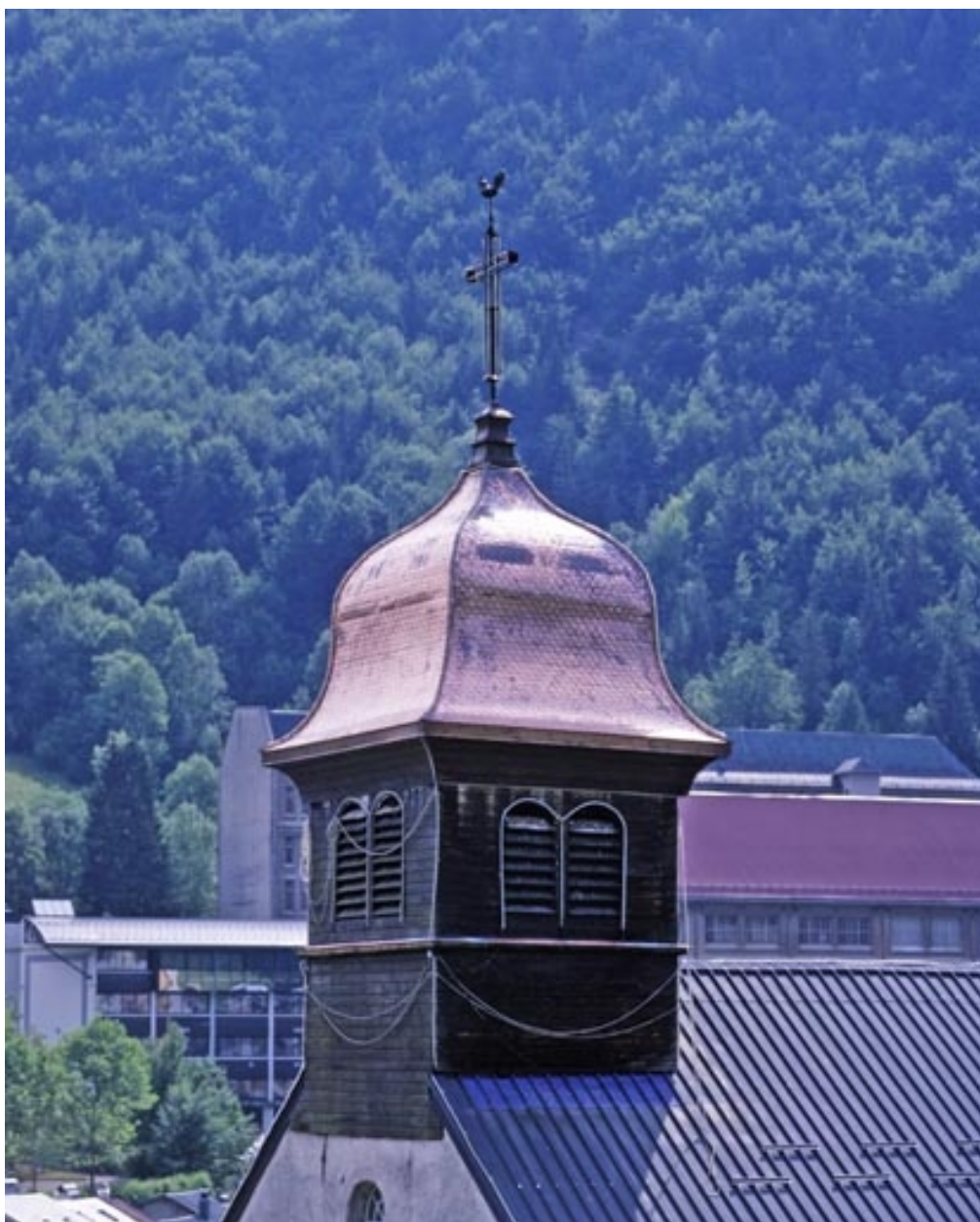
Clocher, depuis le nord-ouest.
