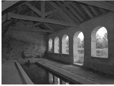
Vue d'ensemble intérieure Phot. Jean-Luc Duthu IVR26_19748901024V
