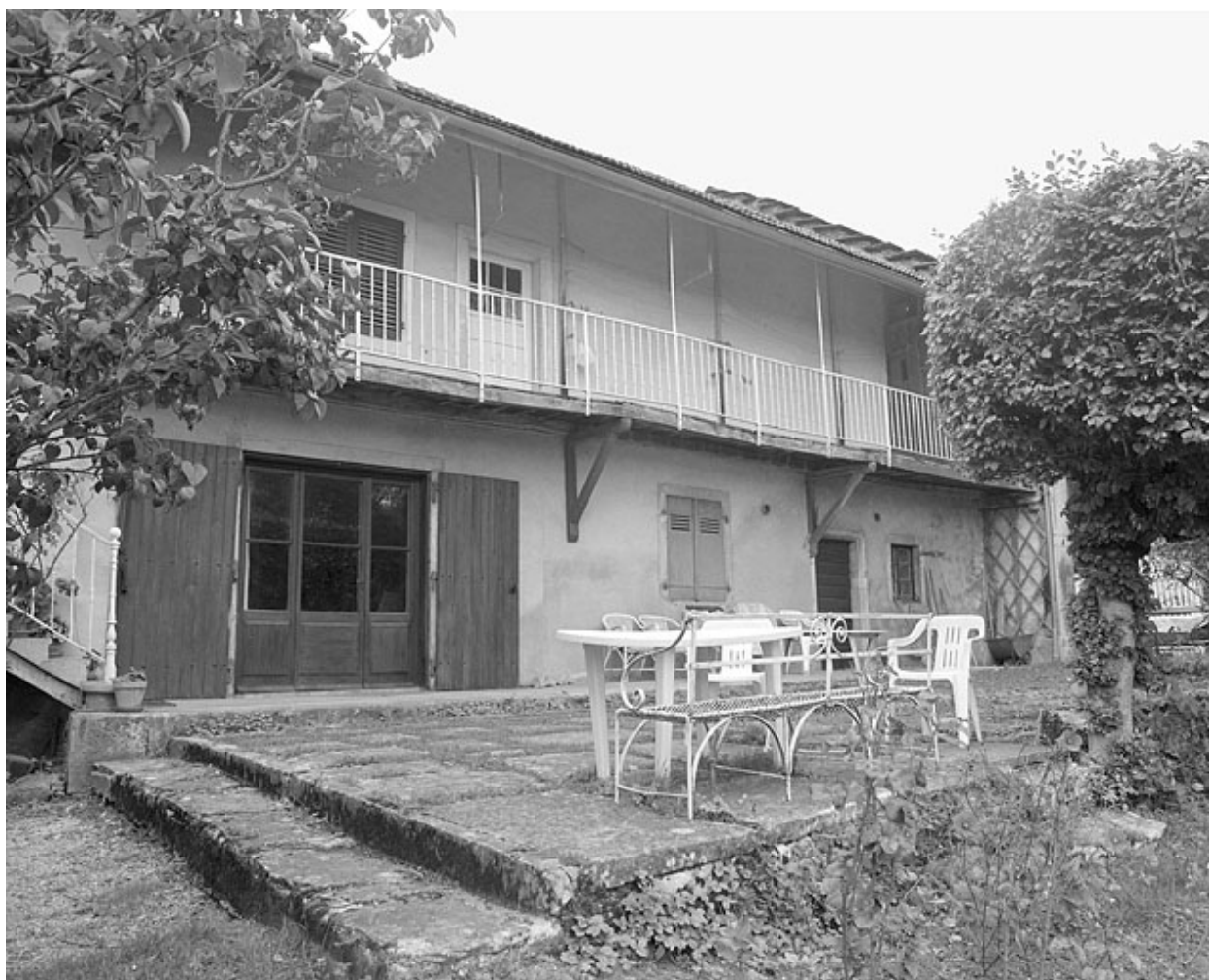
Façade postérieure de la ferme.
