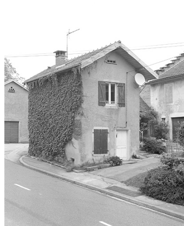
La buanderie aménagée en logis. Phot. Jérôme Mongreville IVR43_19963901434X
