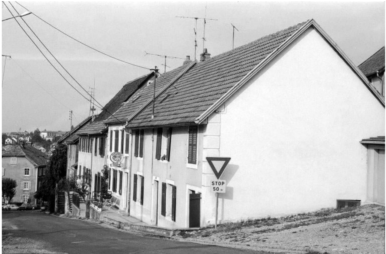
Alignement de maisons, rue de Montbouton.
