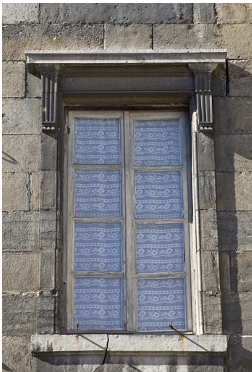
Aile droite : détail d'une fenêtre, de face.
