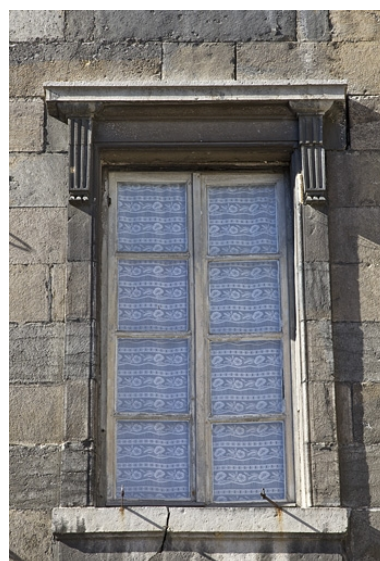
Aile droite : détail d'une fenêtre, de face. Phot. Yves Sancey IVR43_20112500670NUC2A
