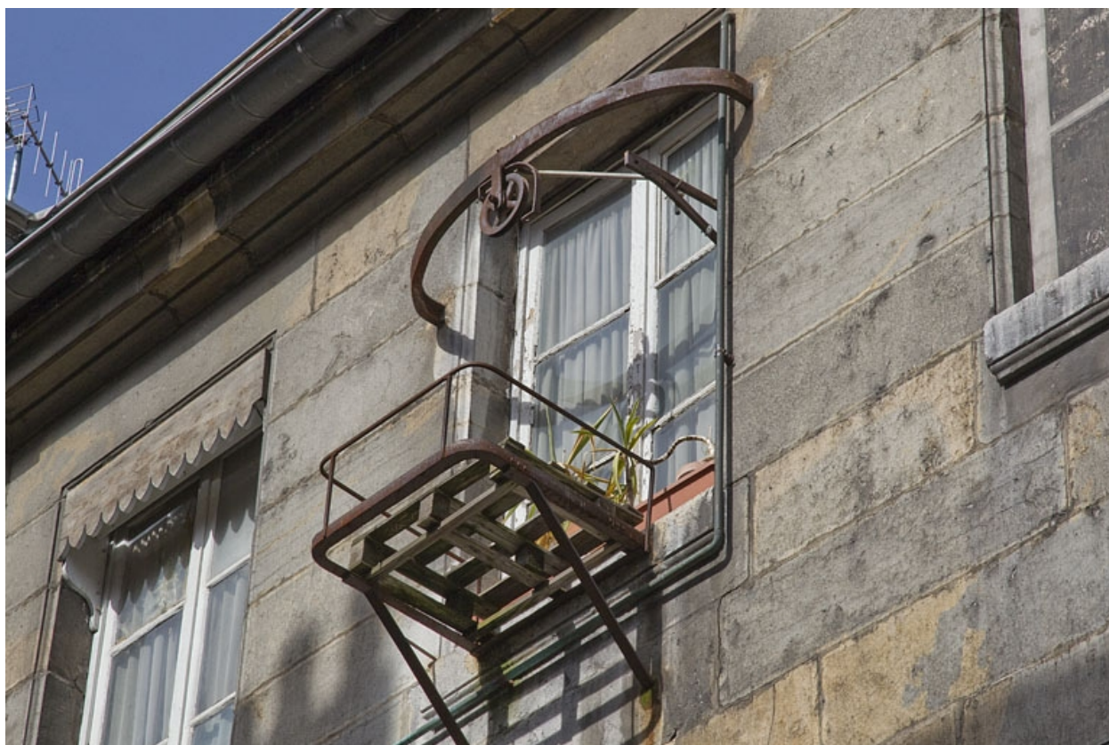
Aile gauche : détail d'un monte-charge.
