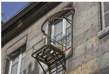
Aile gauche : détail d'un monte-charge.
