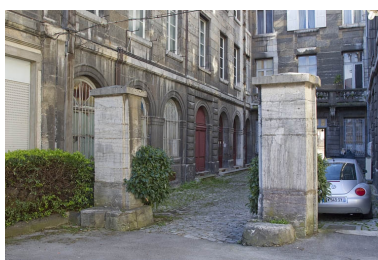
Aile droite : détail du rez-de- chaussée, de trois quarts gauche. Phot. Yves Sancey IVR43_20112500671NUC2A
