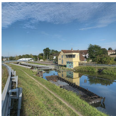
Site d'écluse pris d'amont. Phot. Thierry Kuntz IVR26_20127100310NUC4A
