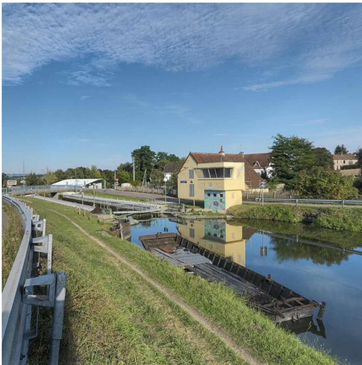
Site d'écluse pris d'amont.
