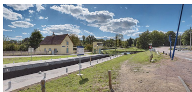
Site d'écluse pris d'aval. Phot. Thierry Kuntz IVR26_20127100306NUC4AQ
