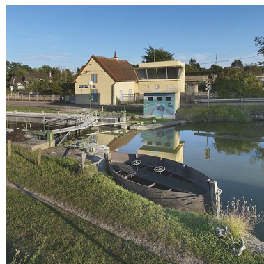
Site d'écluse pris d'amont. Phot. Thierry Kuntz IVR26_20127100311NUC4A
