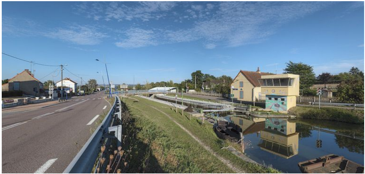
Site d'écluse pris d'amont.
